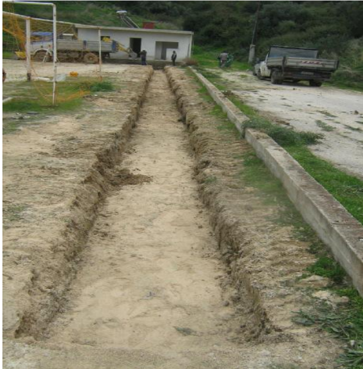
Εικόνα 3.2: Κατασκευή βάσης περίφραξης
