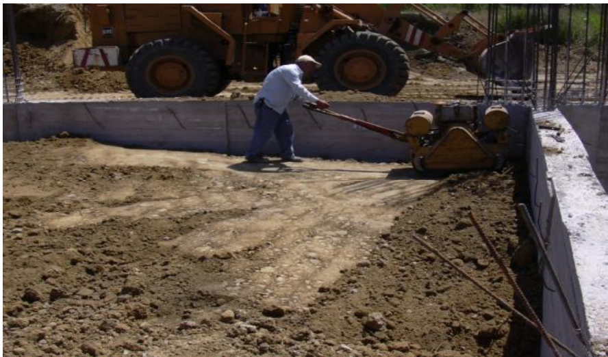
Εικόνα 3.3: Κατασκευή θεμελίων αποδυτηρίων
