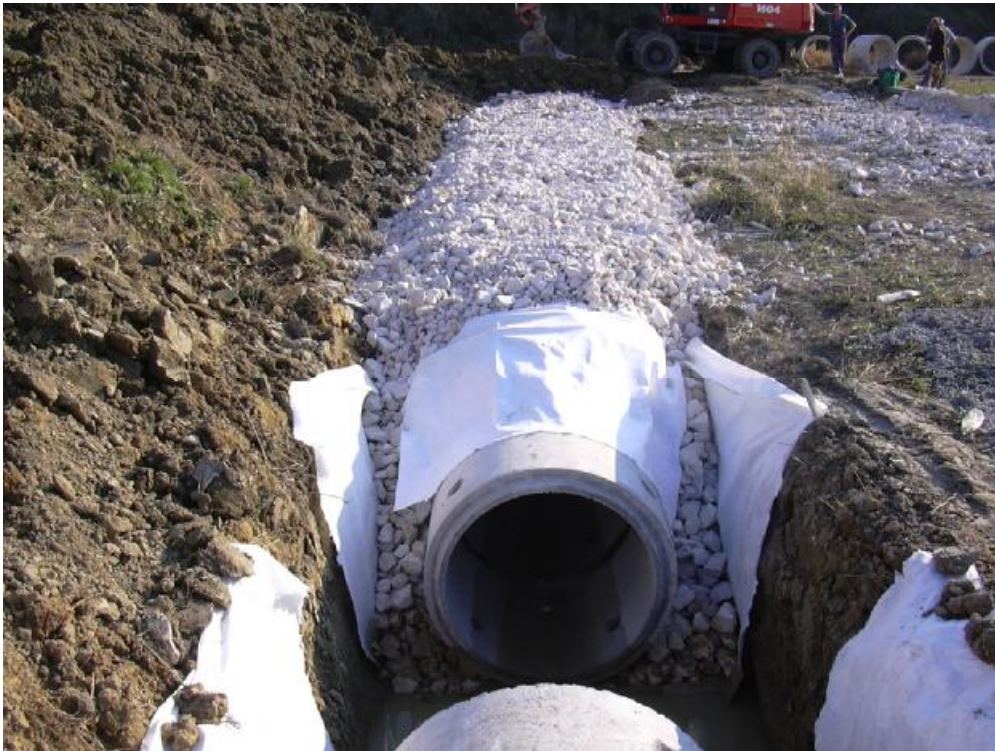
Εικόνα 3.1: Κατασκευή αποστραγγιστικού δικτύου
