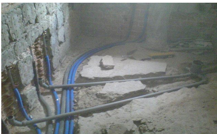
Εικόνα 3.10: Κατασκευή δικτύου αποχέτευσης
