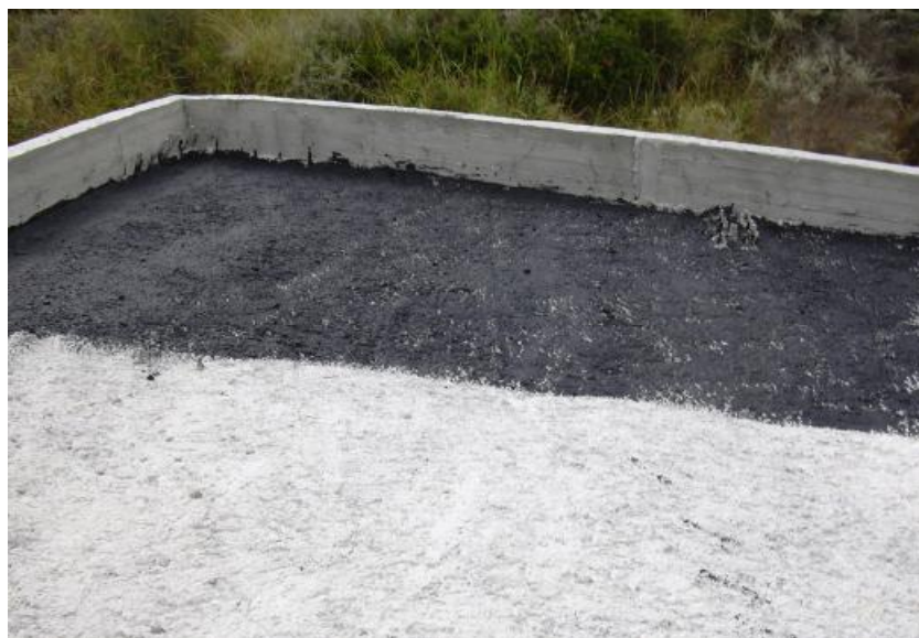
Εικόνα 3.4: Κατασκευή μόνωσης
