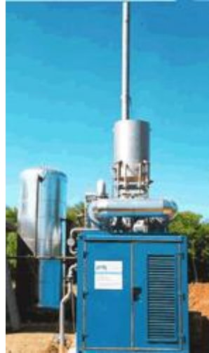
Εικόνα 8.2: Μονάδα παραγωγής 250kW ηλεκτρικής ενέργειας και 100kW θερμικής ενέργειας με την καύση βιοαερίου.
