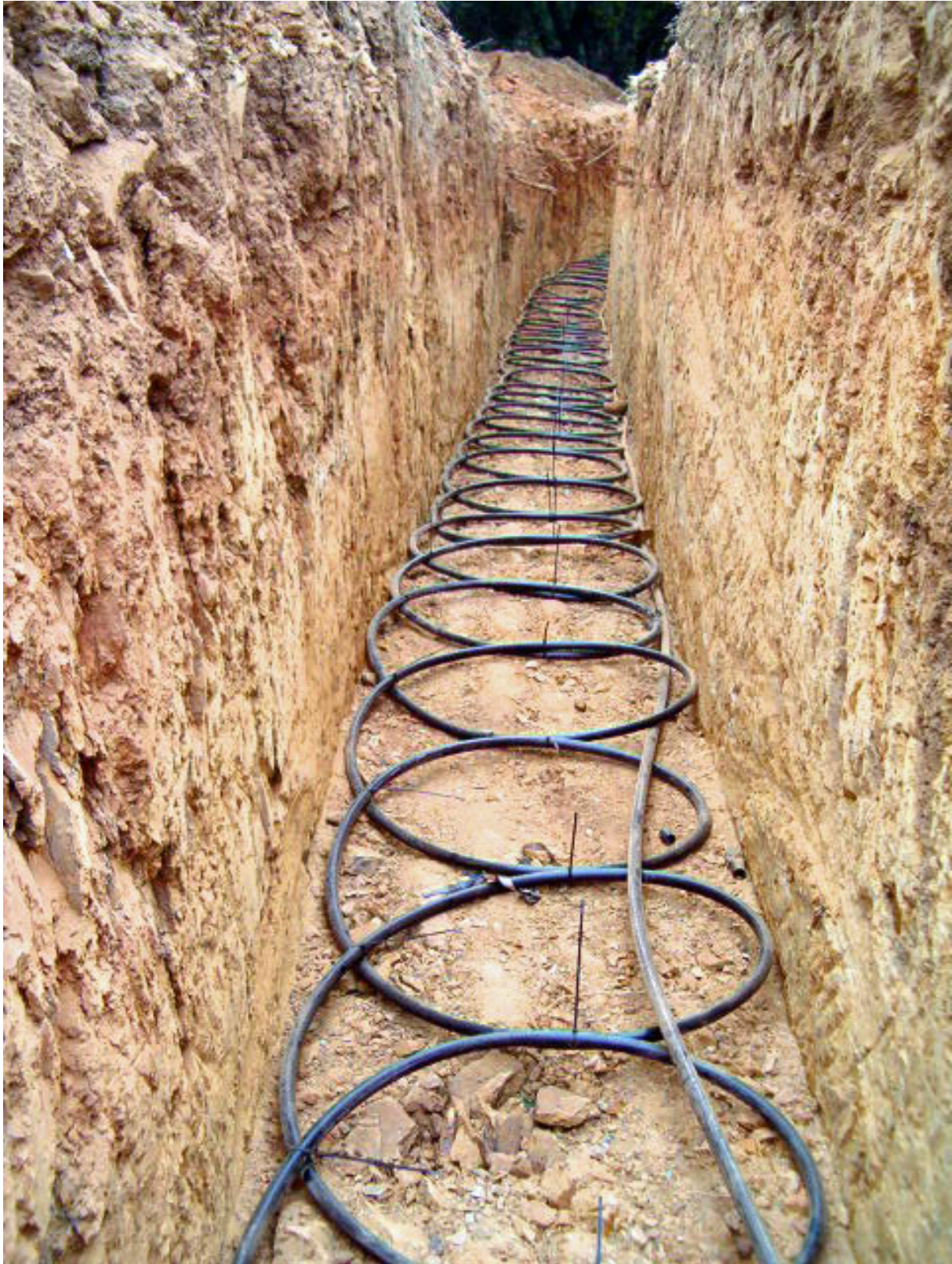
Σχήμα 7.32: Τοποθέτηση υπεδάφιων σωληνώσεων σε σπειροειδή διάταξη ( www.s-v.gr/cms/geothermalphotos.html )
