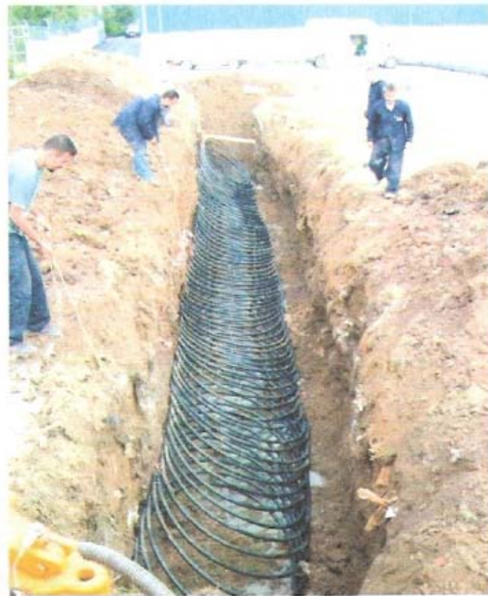
Σχήμα 7.31: Τοποθέτηση υπεδάφίων σωλήνων σε σπειροειδή διάταξη (Trastic Enterprises, Πλαστικοί σωλήνες και εξαρτήματα από PE, Τεχνικό φυλλάδιο)
