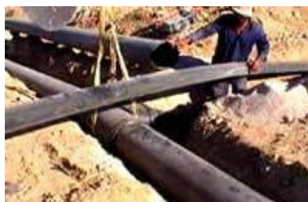
Σχήμα 21 Σύνδεση αγωγών συλλογής βιο-αερίου από HDPE ( www.biofuels.gr )
