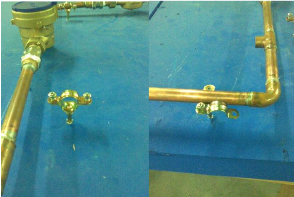
Εικόνα 41: Τοποθέτηση συσκευής στα δακτυλίδια στήριξης
