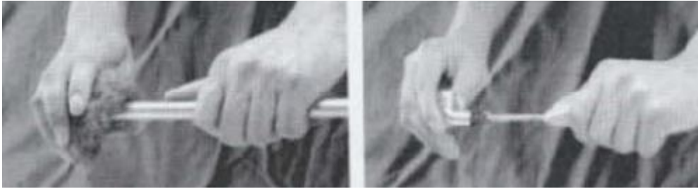
Εικόνα 19: Καθαρισμός επιφάνειας κόλλησης
