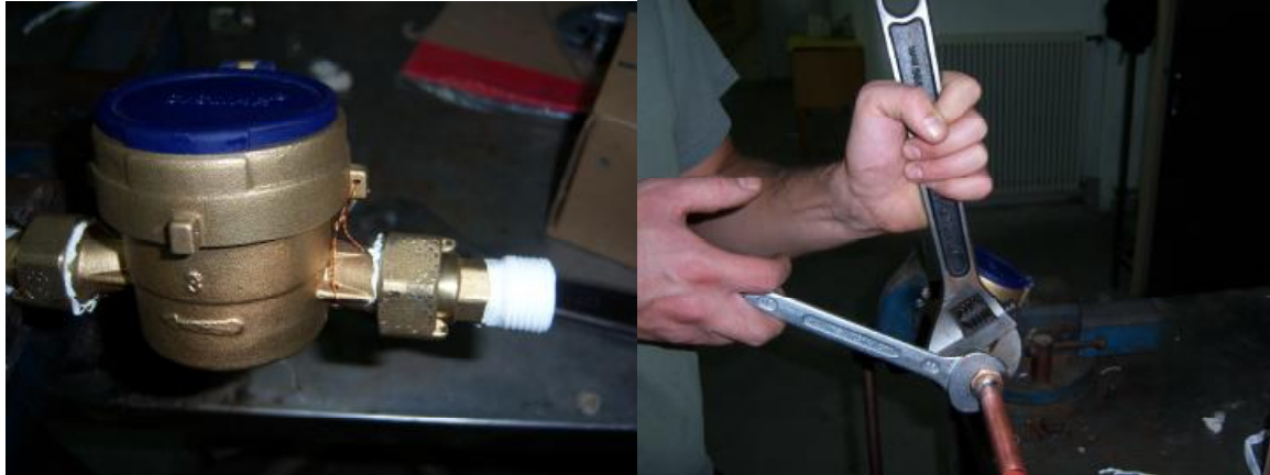
Εικόνα 40: Σύσφιξη τεμαχίων
