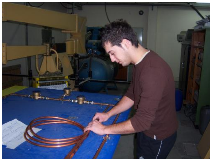
Εικόνα 43: Τοποθέτηση σπирάλ σωλήνας
