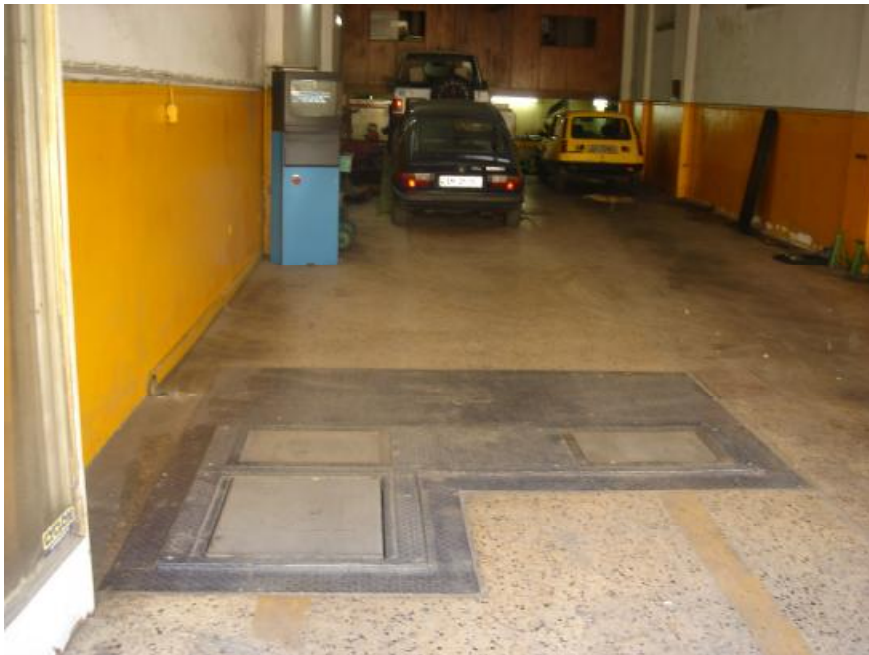
Εικόνα 4.10: Διάταξη ελέγχου απόδοσης αμορτισέρ
