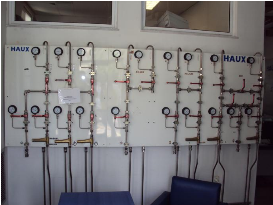
Εικόνα 34: Κεντρικό πάνελ αερίων
