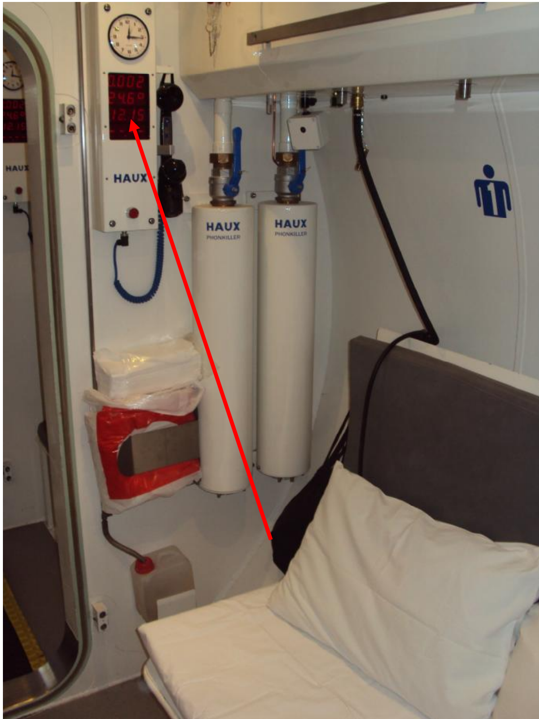
Εικόνα 33: Όργανα μέτρησης χρόνου, θερμοκρασίας και πίεσης
