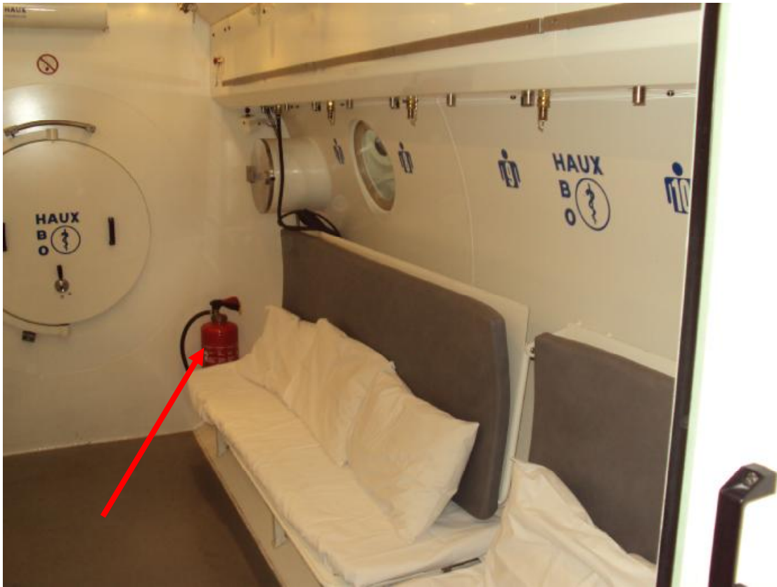
Εικόνα 31: Πυροσβεστήρας μέσα στον θάλαμο
