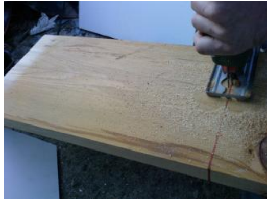
Εικόνα 4.29: κατασκευή βάσης κινητήρα
