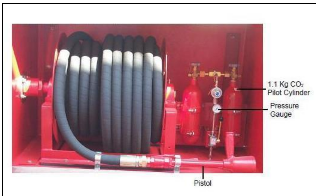
Σχήμα 12.3 : Μάνικα Χειροκίνητου Συστήματος Κατάσβεσης
