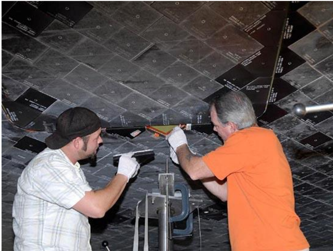
Σχήμα 5.4 Τοποθέτηση μονωτικών πλακιδίων στην άτρακτο του διαστημικού οχήματος .
