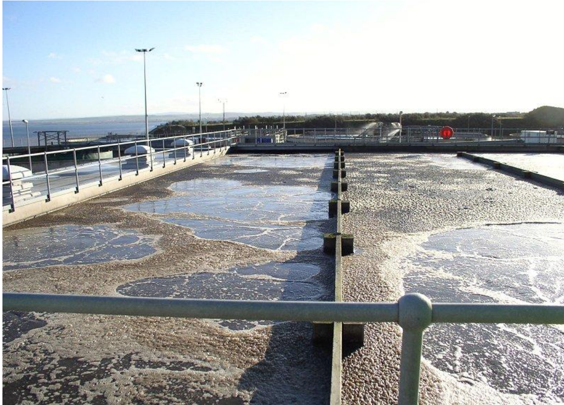
Εικόνα 3.2: Δεξαμενη αερισμου
