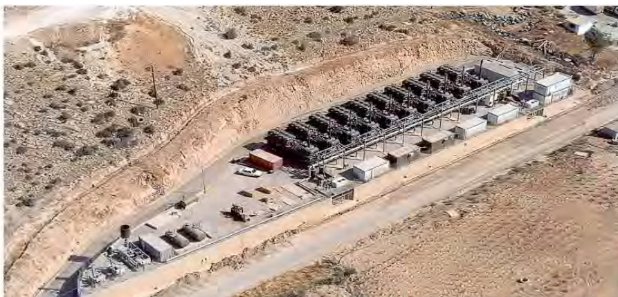
Εικόνα 13.2: Σταθμός ηλεκτροπαραγωγής με καύση βιοαερίου στα Άνω Λιόσια (Πηγή: ΗΛΕΚΤΩΡ Α.Ε.)
