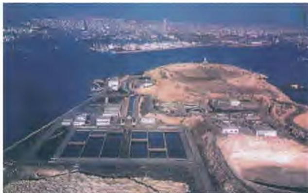
Εικόνα 13.1 . Μονάδα επεξεργασίας λυμάτων στη Ψυτάλλεια (Πηγή: ΕΥΔΑΠ)
