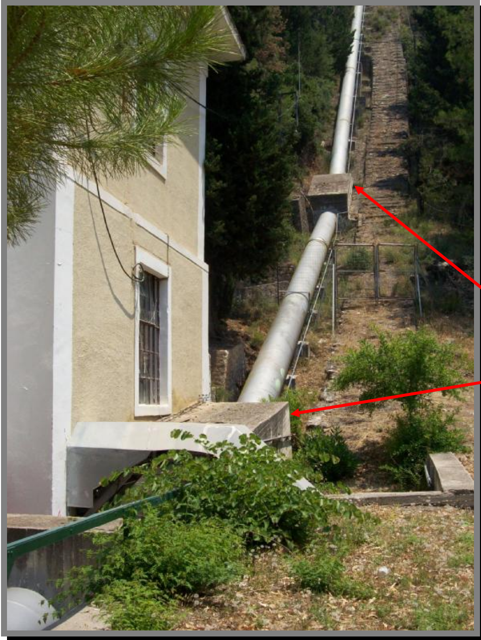
Εικόνα 63: Πάκτωση αγωγού πτώσεως σε αλλαγή κλίσης του
