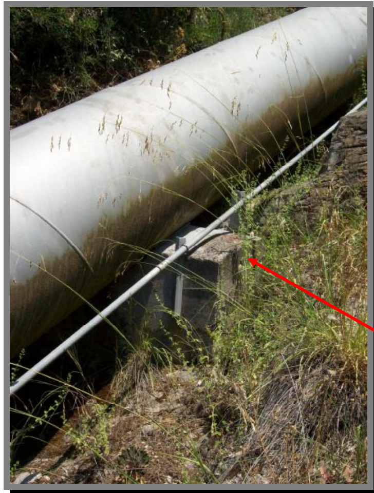
Εικόνα 62: Σημείο στήριξης αγωγού πτώσεως
