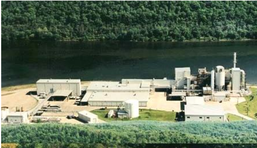
Σχήμα 33 : Εγκαταστάσεις ανάκτησης ενέργειας από την εταιρία Von Roll στο Ohio
