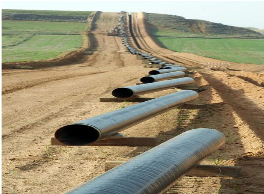
Εικόνα 10. Κατασκευή αγωγού φυσικού αερίου
