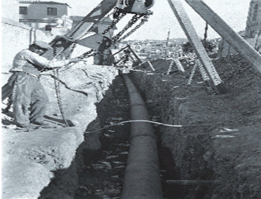
Εικόνα 2. Τοποθέτηση αγωγού ύδρευσης το 1953
