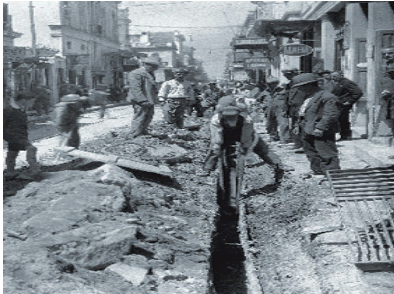
Εικόνα. 1. Τοποθέτηση αγωγού μεταφοράς νερού εντός πόλεως το 1953
