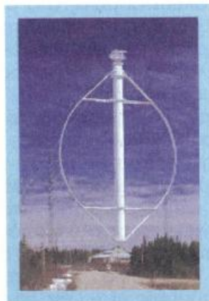
Σχήμα 1.2. Ανεμογεννήτρια κατακόρυφου άξονα
