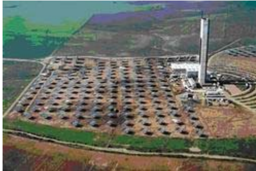
Σεβίλη: Η πρώτη μονάδα περιλαμβάνει 624 κινούμενα κάτοπτρα με επιφάνεια 121 τμ το καθένα, σε έκταση 700 στρεμμάτων
