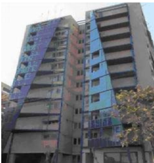
Ενσωμάτωση φωτοβολταϊκών σε πολυκατοικίες στον Ταύρο
