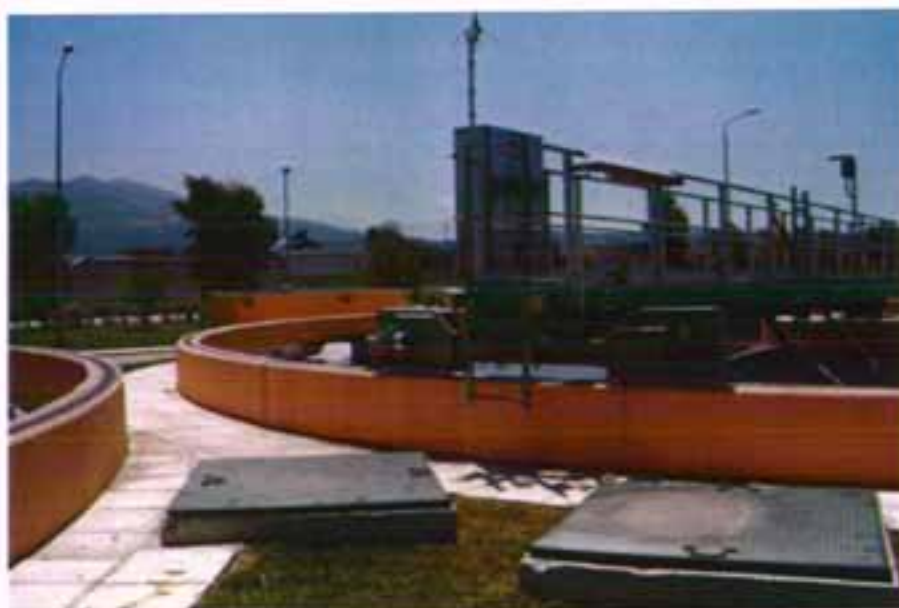
Δεξαμενές Πρωτοβάθμιας καθίζησης – Φρεάτιο Μερισμού
