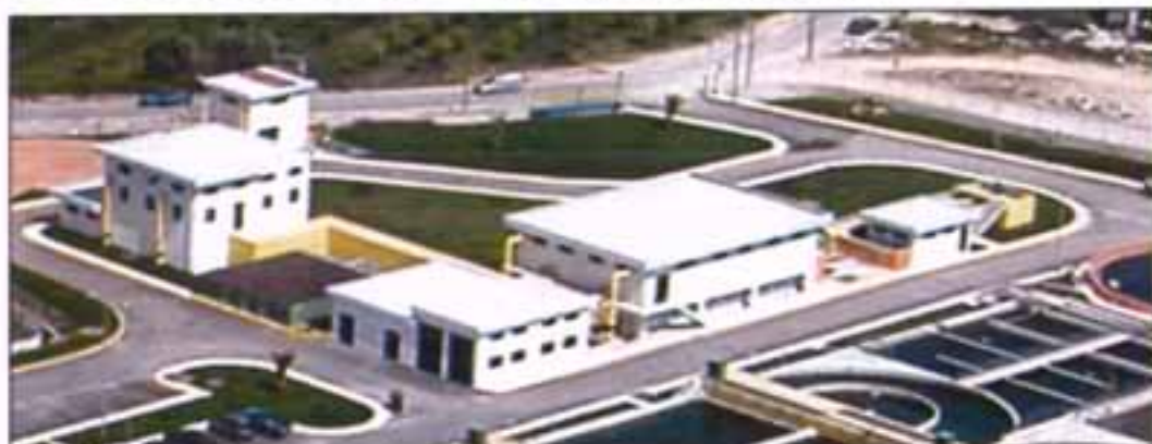
Γενική άποψη των κτιρίων στην είσοδο – προεπεξεργασία λυμάτων
