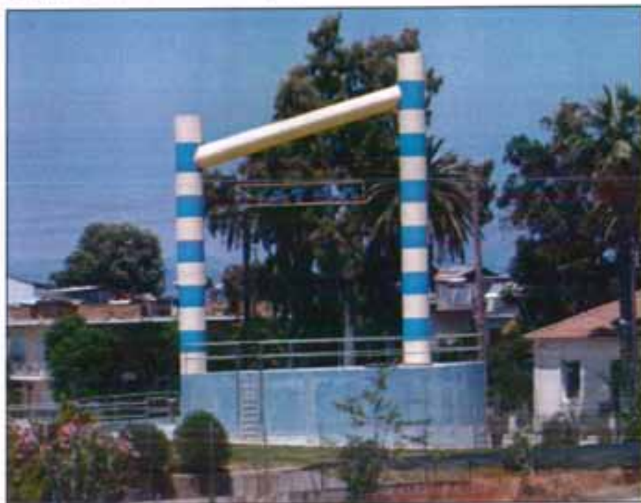
Το αντλιοστάσιο εξόδου (βρίσκεται κάτω από την επιγραφή της φωτογραφίας )
