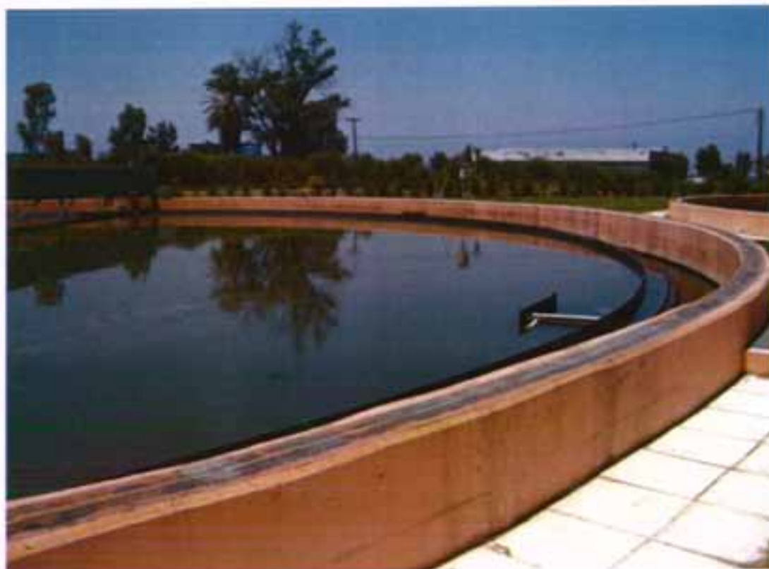
Κοντινό πλάνο ΔΔΚ (Διακρίνεται ο υπερχειλιστής και η γέφυρα)
