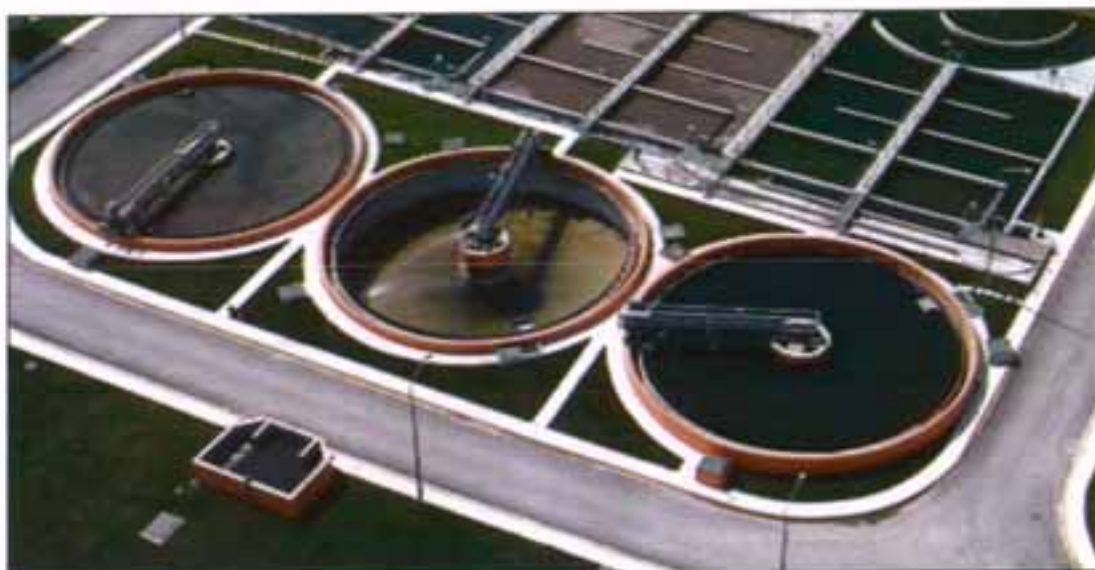
Δεξαμενές Πρωτοβάθμιας καθίζησης – Φρεάτιο Μερισμού
