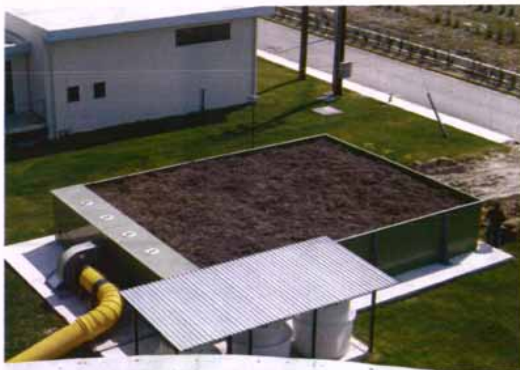
Εγκατάσταση απόσμησης έργων προεπεξεργασίας
