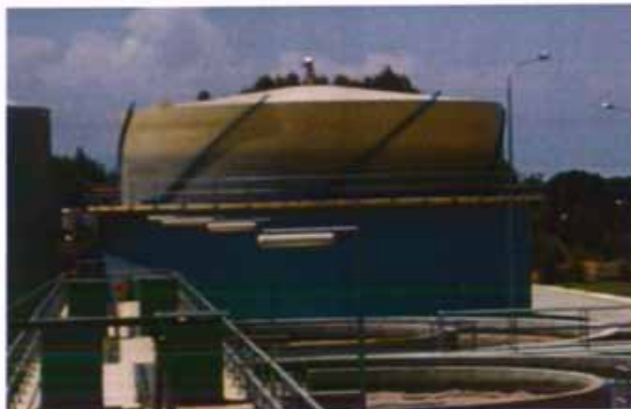
Αεριοφυλάκιο αποθήκευσης βιοαερίου
