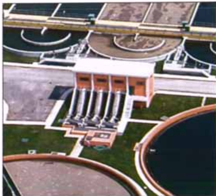
Αντλιοστάσιο Ανακυκλοφορίας ιλύος (Μεταξύ οξειδωτικών τάφρων και ΔΔΚ)
