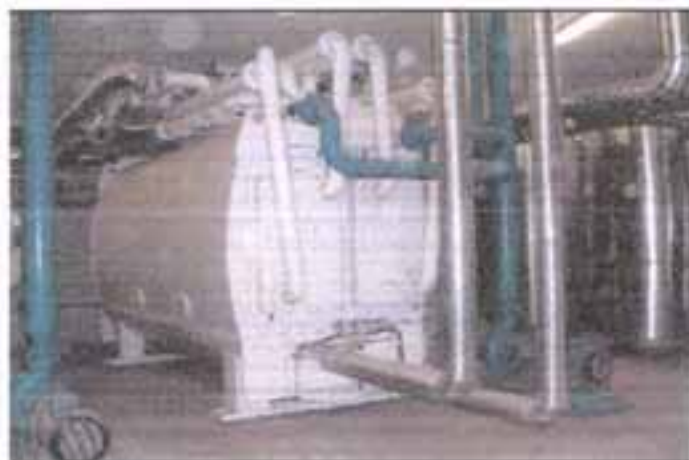
Σχήμα 6,3 Ψύκτης προσρόφησης 350kW - Βιομηχανία Σαράντης Α.Ε.- Ελλάδα
