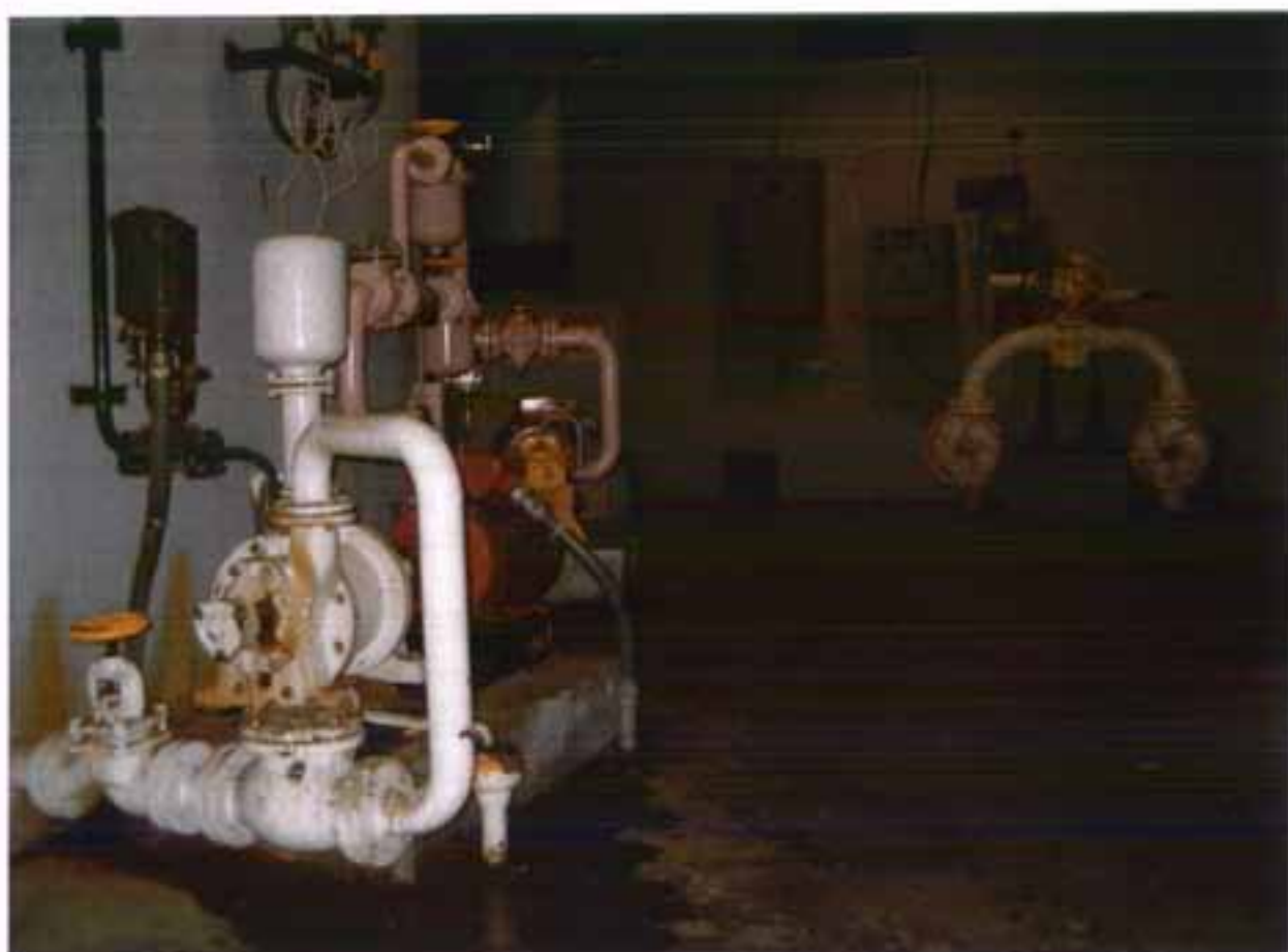
Πιεσόμετρα Σύστημα αέρα για τον υποβιβασμό της στάθμης νερού
