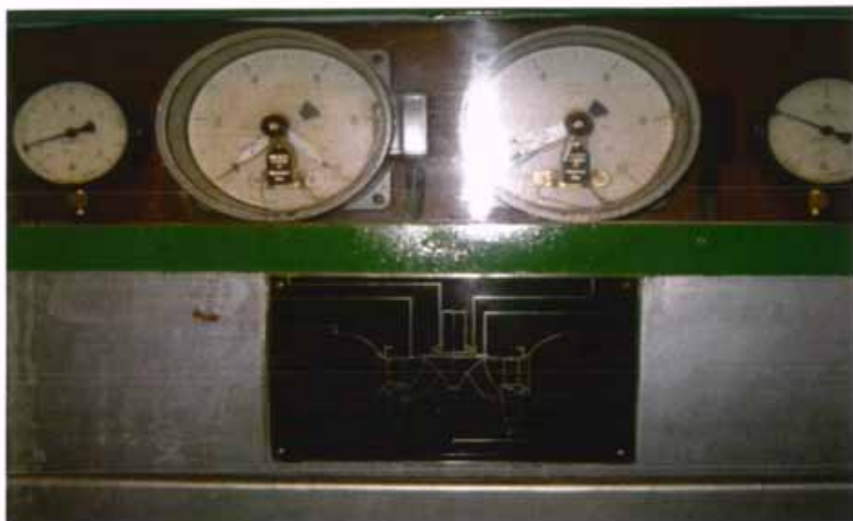
Πιεσόμετρα Σύστημα αέρα για τον υποβιβασμό της στάθμης νερού
