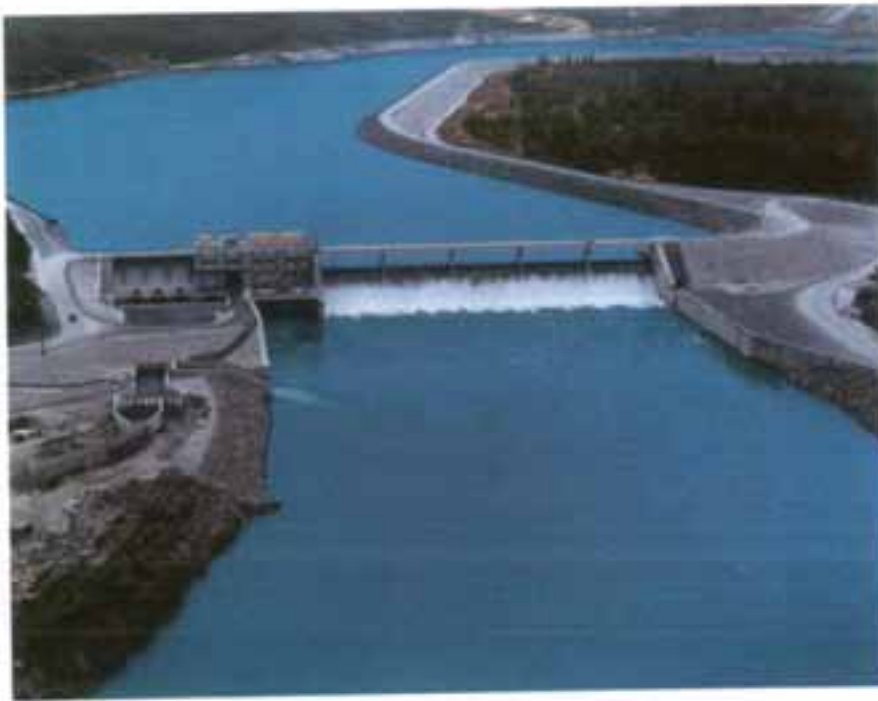
Σχήμα 1.3: Υδροηλεκτρικό εργοστάσιο στον ποταμό Αραχθό (φράγμα Πουρναρίου). Συνολική εγκατεστημένη ισχύς: δυο κύριες μονάδες των 15MW και μια μονάδα των 1.5MW. Ύψος του σκυροδέματος του φράγματος: 40m
