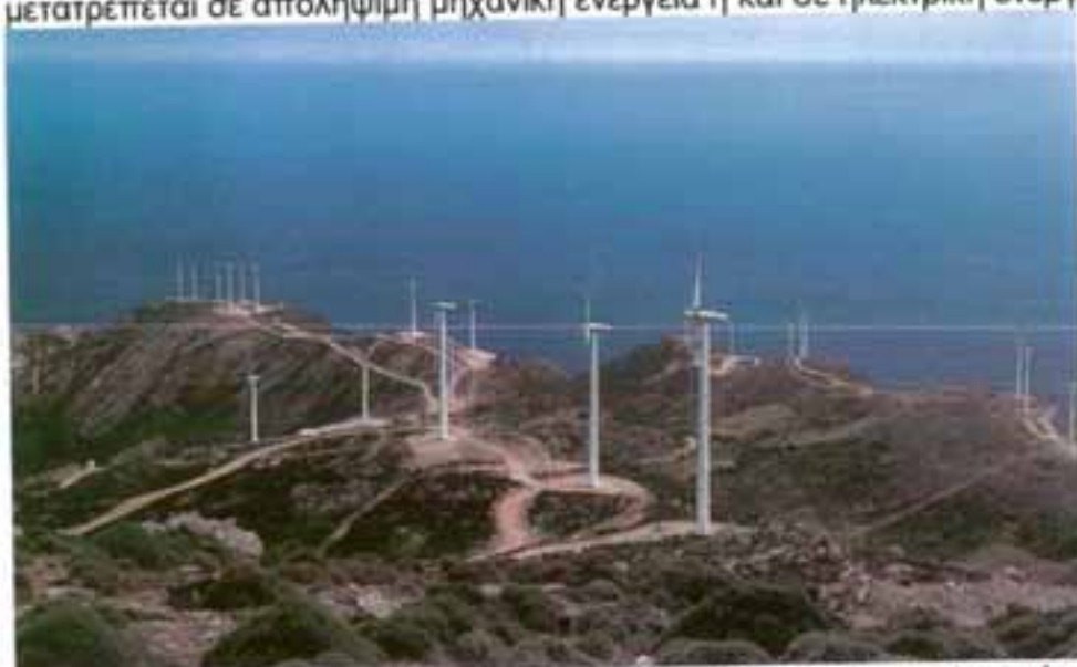
Σχήμα 1.5: Αιολικό ιδιωτικό πάρκο στην Νότια Εύβοια (Κάρυστος) κατασκευασμένο από την Ρόκας Α.Β.Ε.Ε. ισχύος 24 MW.
