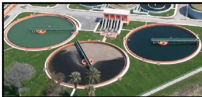
Εικόνα 3.6. Δεξαμενές καθίζησης
