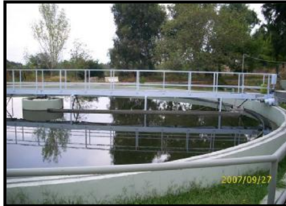
Εικόνα 3.7. Δεξαμενη τελικής καθίζησης.
