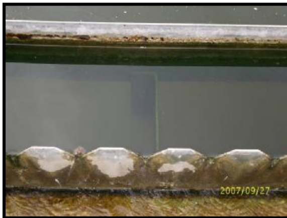
Εικόνα 3.8. Περιφερειακός οδοντωτός υπερχειλιστής.
