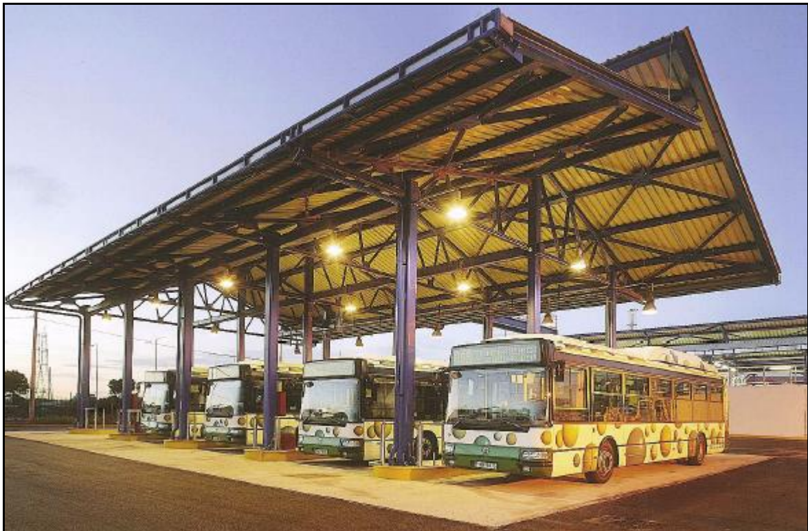
Εικόνα 1.11 Σταθμός ανεφοδιασμού CNG στην Ανθούσα Αττικής.
