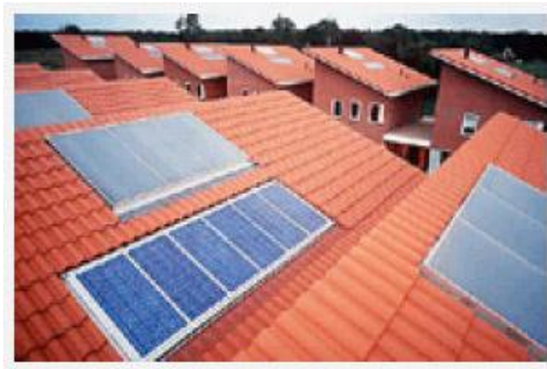
Εικ.3.2 Φωτοβολταϊκά ενσωματωμένα σε κτίρια
