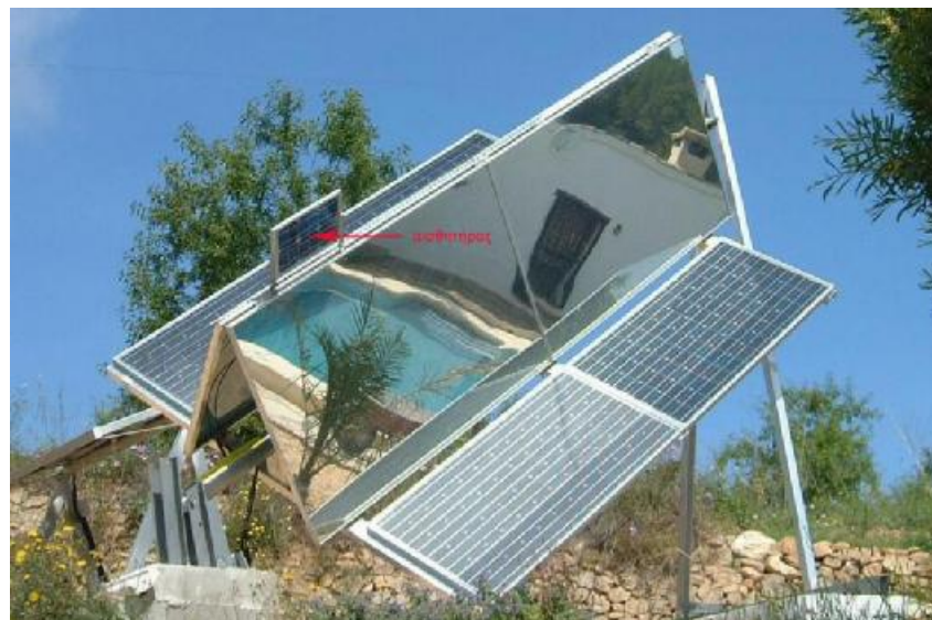
Εικ.3.8 Πολικό ηλιοτρόπιο με ενσωματωμένους ανακλαστήρες για αύξηση της προσπίπτουσας ακτινοβολίας στα φωτοβολταϊκά πλαίσια. Διακρίνεται και το μικρό ΦΒ που χρησιμοποιείται σαν αισθητήρας για τον προσδιορισμό της θέσης του ηλιοτροπίου
