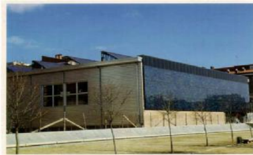
Εικ.3.2 Φωτοβολταϊκά ενσωματωμένα σε κτίρια
