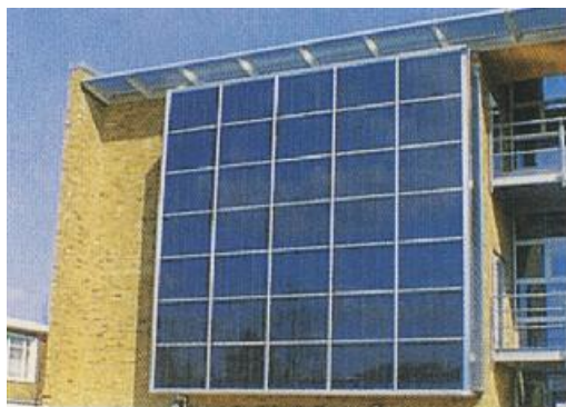
Σχήμα 10.2 Εφαρμογές pv πλαισίων σε νέα κτίρια.
