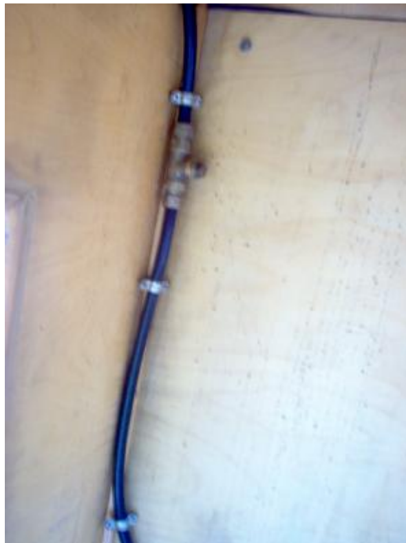
Σχήμα 23.Πλαστική σωλήνα κυκλώματος και αναμονή.
