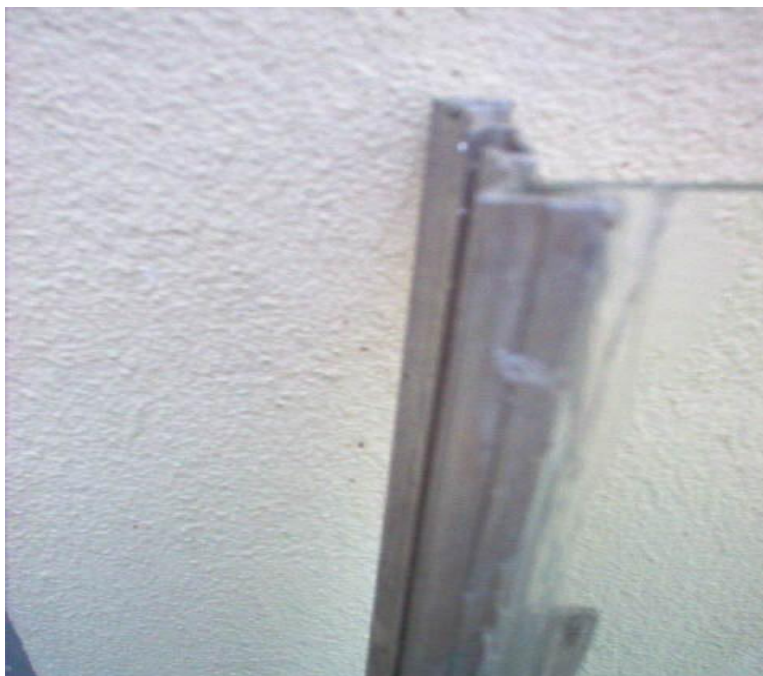
Σχήμα 2.Κόλληση πλαισίου με σιλικόνη
