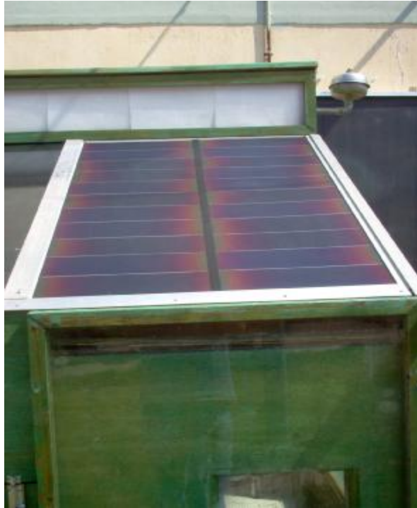
Τελική άποψη του PV-στέγη
