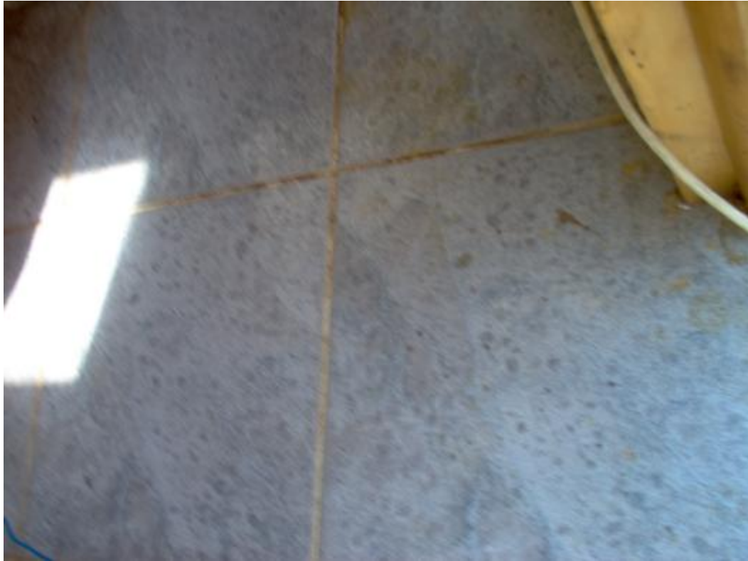
Σχήμα 6. Τοποθέτηση πλακιδίων και δημιουργία αρμών.
