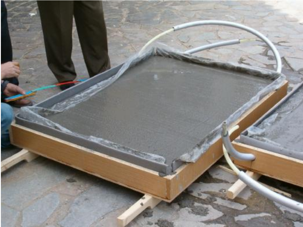
Σχήμα 5.Επικάλληψη με σκυρόδεμα.
