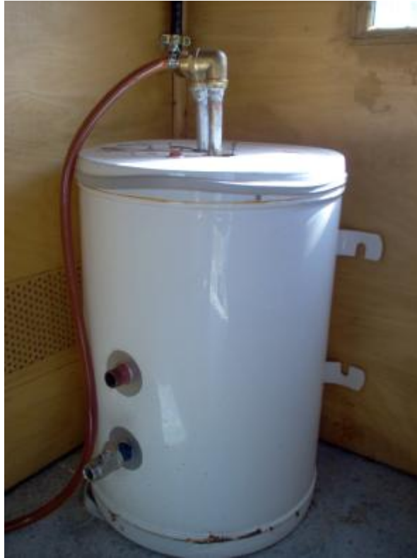
Σχήμα 19.Boiler 25 lt.
