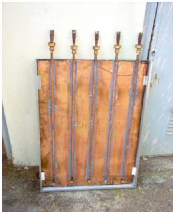
Σχήμα 8. Τοποθέτηση χαλκού στο πλαίσιο αλουμινίου.
