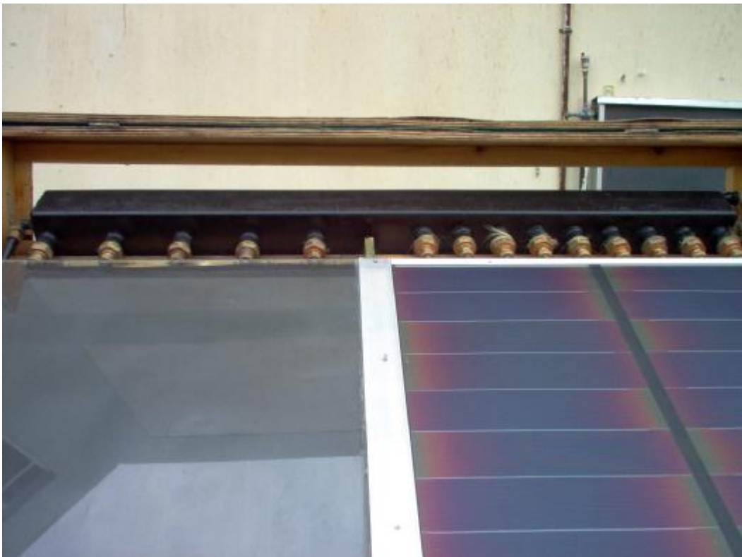
Σχήμα 18.Σύνδεση εναλλάκτη με PV-συλλέκτη
