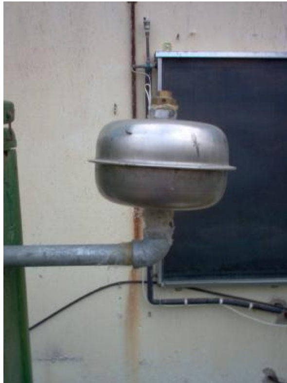
Σχήμα 21. Δοχείο διαστολής.
