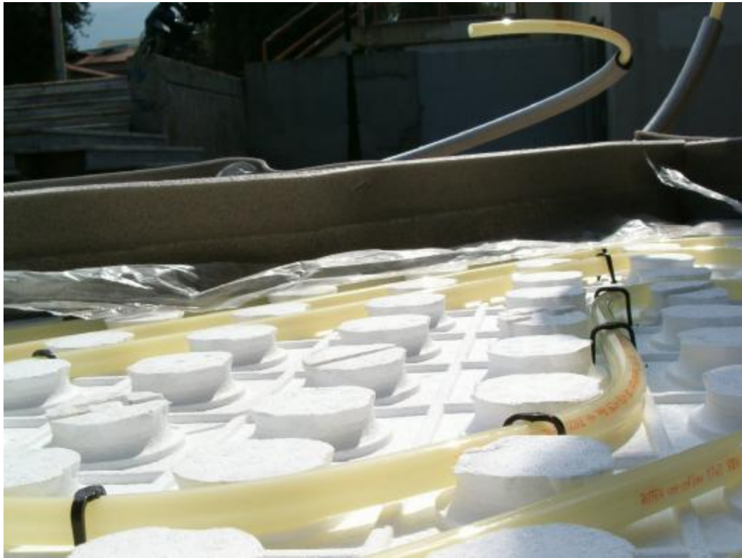
Σχήμα 3. Μόνωση και πλαστικός σωλήνας.
