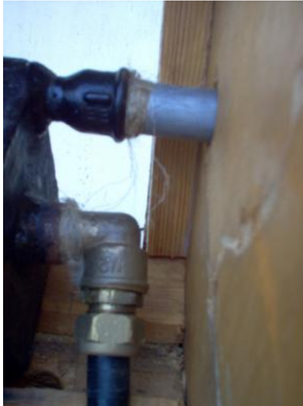
Σχήμα 14.Σημεία σύνδεσης εναλλάκτη με κύκλωμα και δοχείο διαστολής.
