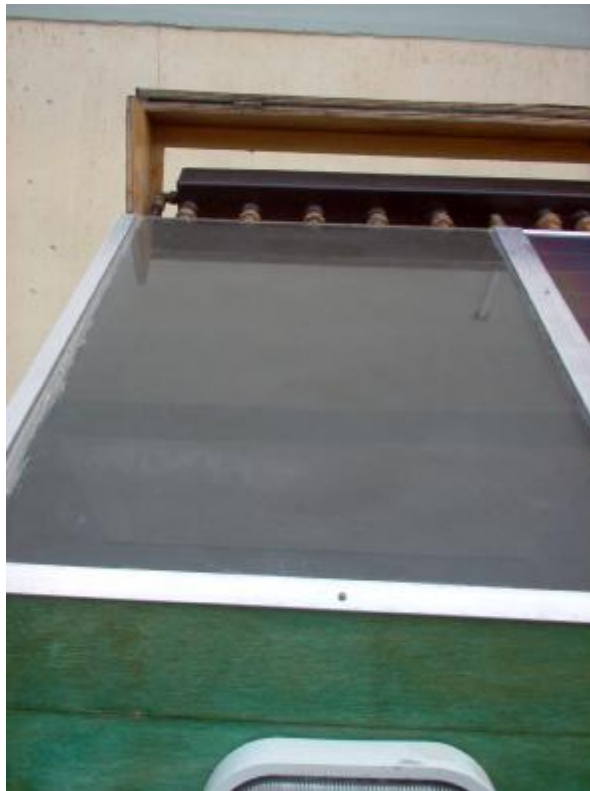
Τελική άποψη του συλλέκτη-στέγη
