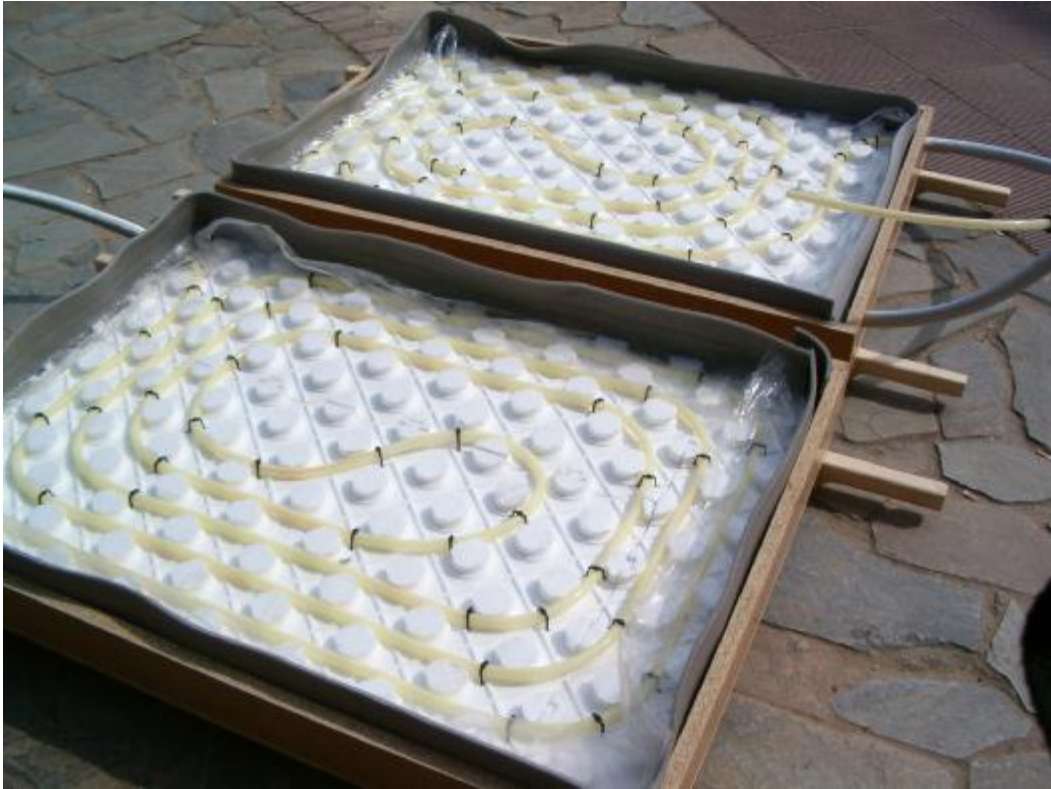
Σχήμα 2..Διαδικασία κατασκευής. Τοποθέτηση πλαστικού σωλήνα πάνω από τη μόνωση.
