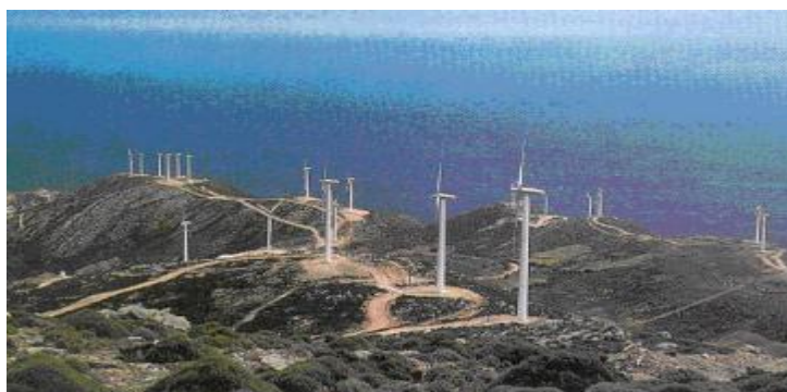
Σχήμα 6 : Ανεμογεννήτριες στην Εύβοια
