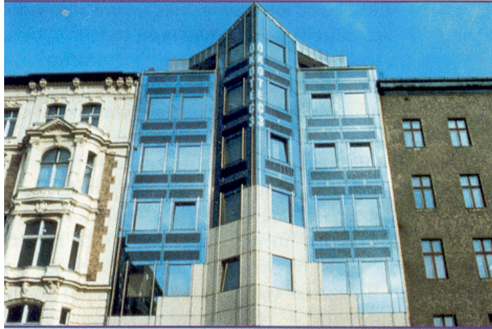
Φωτοβολταϊκό σε πρόσοψη κτιρίου
