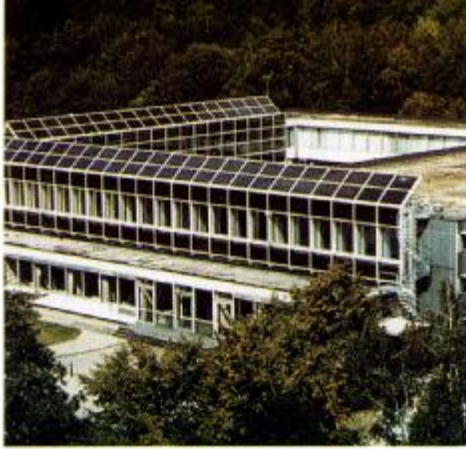
Σχήμα Κεντρικό κτίριο βιβλιοθήκης του Ερευνητικού κέντρου Jülich στη Γερμανία. Διακρίνονται στην οροφή τα PV-πλαίσια που απαρτίζουν την PV-γεννήτρια. Φαίνεται το σύστημα των PV-συστοιχιών που μαζί με τα Σ.Κ. και την εποχιακή αποθήκευση του H 2 καλύπτουν τις ενεργειακές ανάγκες του κτιρίου.
