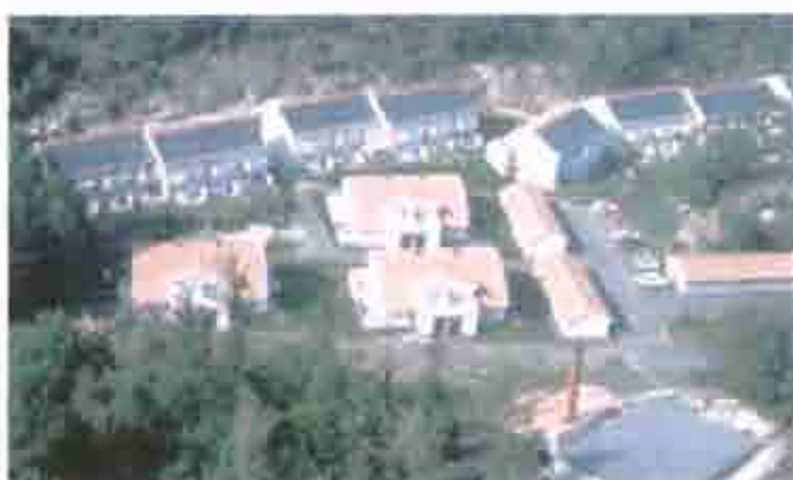
Κατοικίες με φωτοβολταϊκά συστήματα
