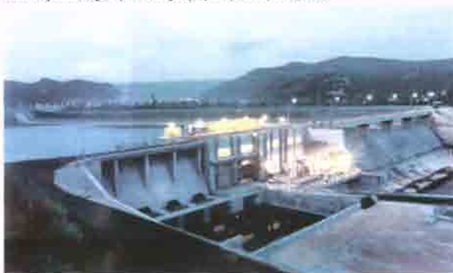
Υδροηλεκτρικός σταθμός ΔΕΗ
