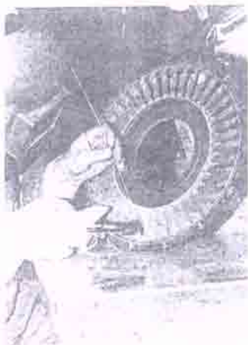
Σχήμα 116. Συγκόλληση πτερυγίων με την μέθοδο του Μικροπλάσματος σε συμπιεστή αεροστροβίλου [5]
