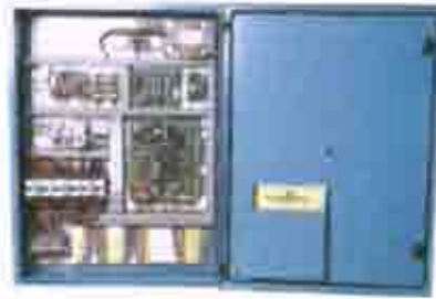
Σχήμα 2.18 : Υδραυλικός πίνακας με εκκίνηση Αστέρα Τριγώνου
