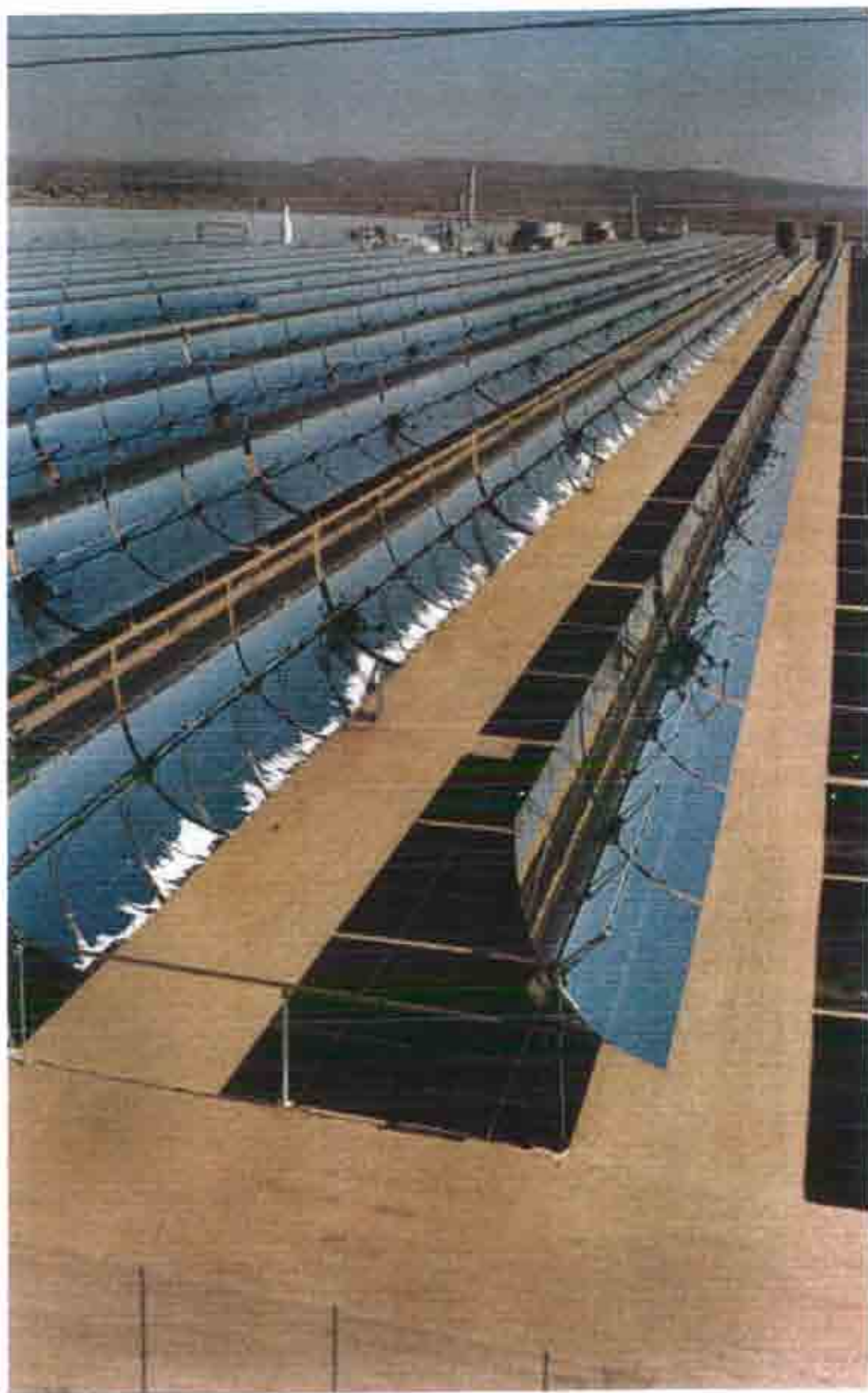
Σχήμα 2.1.2: Συστοιχία συγκεντρωτικών-παραβολικών ηλιακών συλλεκτών.
