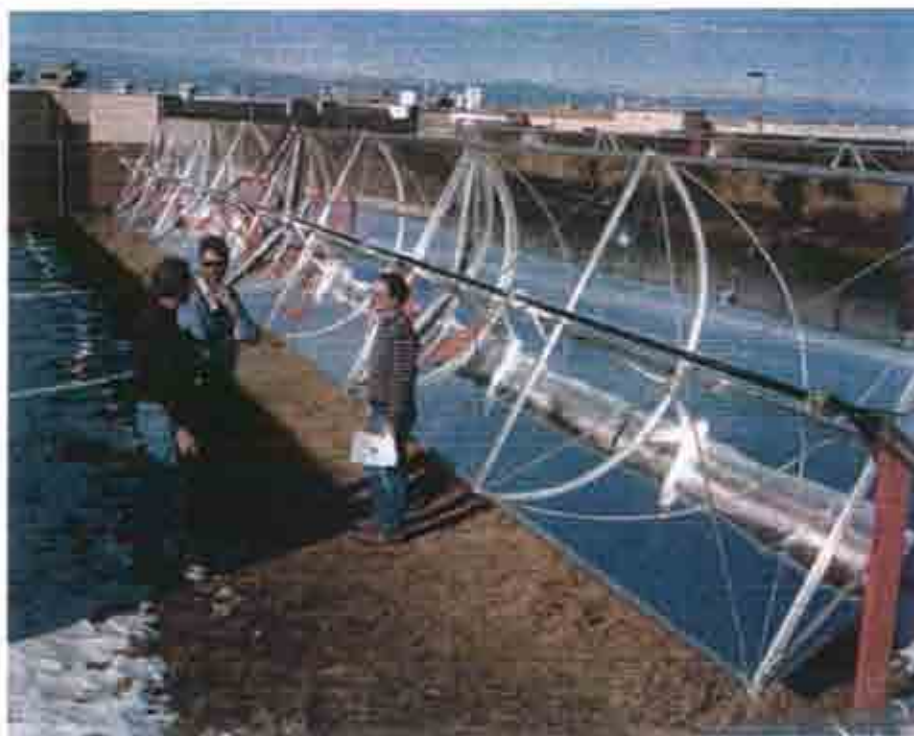
Σχήμα 2.1.1: Συγκεντρωτικοί συλλέκτες με μηχανισμό παρακολούθησης της τροχιάς του ήλιου.
