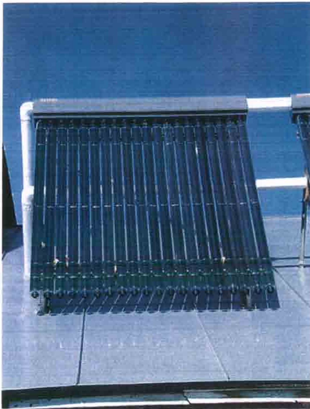
Σχήμα 2.1.6: Ηλιακός συλλέκτης με γυάλινους σωλήνες κενού.
