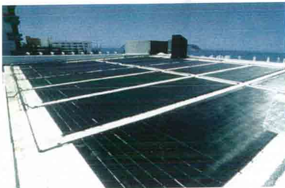
Σχήμα 2.1.10: Συστοιχία επίπεδων ηλιακών συλλεκτών.
