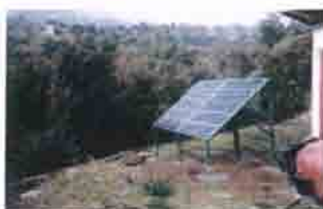
Σχήμα 2.2.23: Αυτόνομο φωτοβολταϊκό σύστημα που ηλεκτροδοτεί εξοχική κατοικία.
