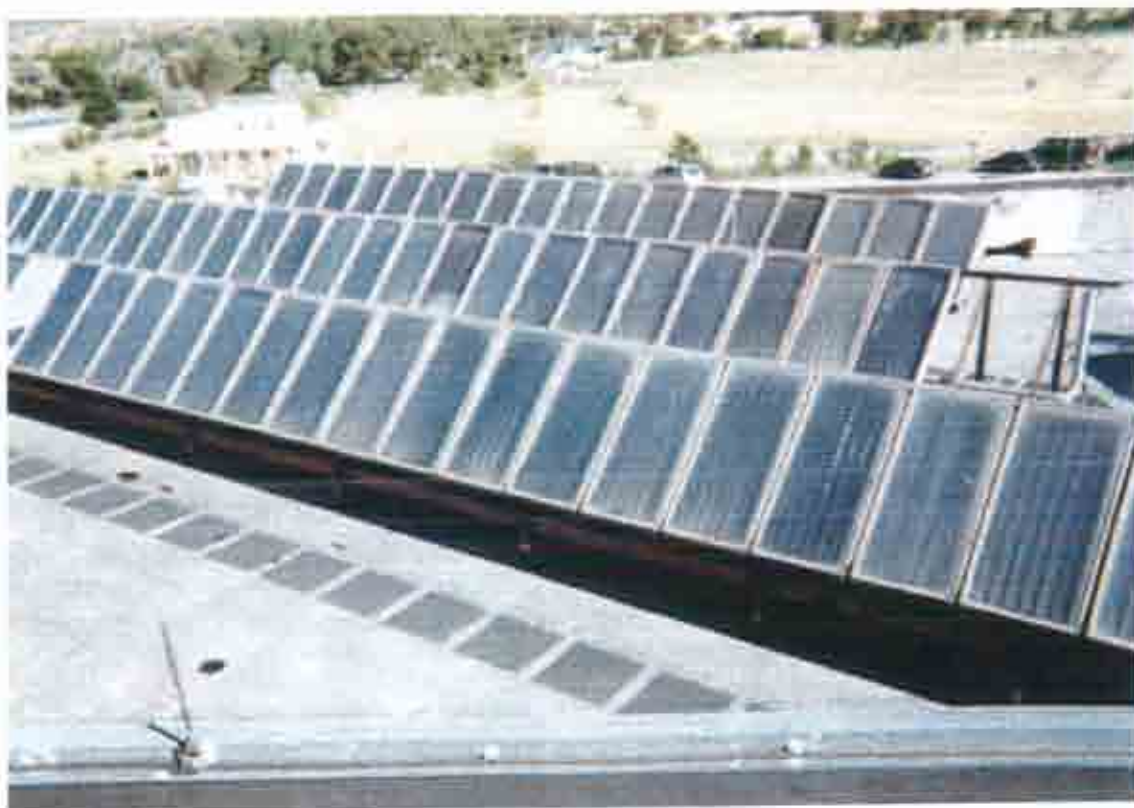
Σχήμα 2.1.9: Εδώ βλέπουμε άλλη μια συστοιχία επίπεδων ηλιακών συλλεκτών για την παραγωγή ζεστού νερού.
