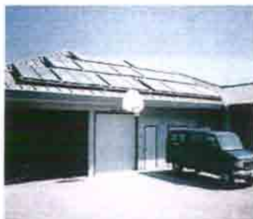
Σχήμα 2.1.8: Συστοιχίες επίπεδων ηλιακών συλλεκτών τοποθετημένες στην οροφή κατοικιών.
