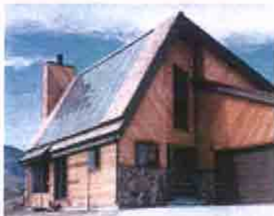
Σχήμα 2.1.8: Συστοιχίες επίπεδων ηλιακών συλλεκτών τοποθετημένες στην οροφή κατοικιών.
