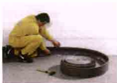
Εικόνα 19: Τοποθέτηση μονωτικής ταινίας
