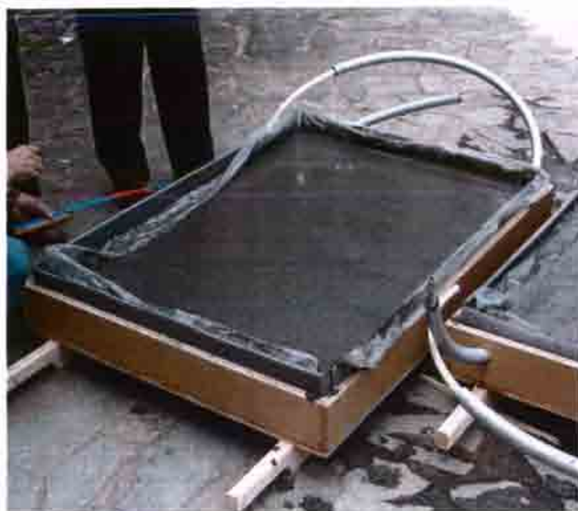
Εικόνα 30: Παρουσίαση του ενδοδαπέδιου συστήματος το οποίο έχει χρησιμοποιηθεί για την κατασκευή του κτιριακού ομοιόματος δοκιμών μετά την επίστρωση του με βετον
