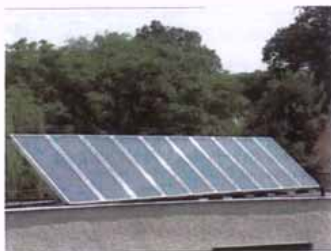
Σχήμα 2.8 Επίπεδος ηλιακός συλλέκτης στην ταράτσα οικίας (πηγή www.physics.4u.gr )
