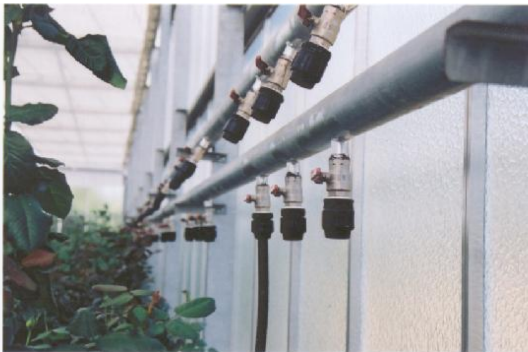
Φώτο 6: Παρατηρούμε τους γαλβαλισμένους σωλήνες θέρμανσης που είναι τοποθετημένοι στην περίμετρο του θερμοκηπίου. Πάνω σ' αυτούς τους σωλήνες υπάρχουν κάποιες βάνες, μέσω των οποίων συνδέονται οι επιδαπέδιοι σωλήνες θέρμανσης με αυτούς της περιμέτρου.
