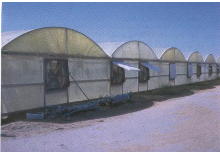
Εικ. 5.6. Ανεμιστήρες για δυναμικό εξαερισμό
