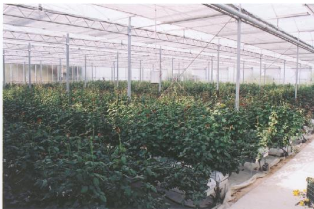
Φώτο 2: Εσωτερική άποψη του θερμοκηπίου. Παρατηρούμε τους γαλβανισμένους στύλους και τα αντιανέμα. Επίσης φαίνεται το δικτύωμα και ο κεντρικός σωλήνας θέρμανσης στην οροφή.
