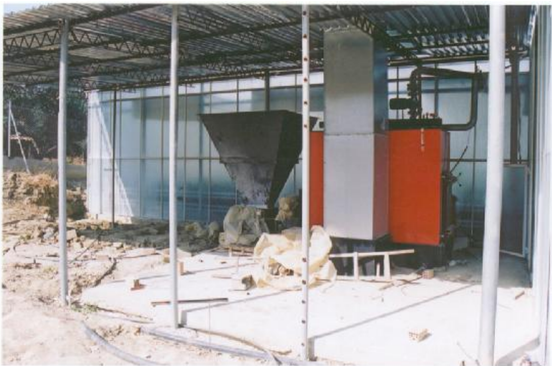
Φώτο 3: Λέβητας πυρηνόξυλου, ο οποίος χρησιμοποιείται για την θέρμανση του θερμοκηπίου.
