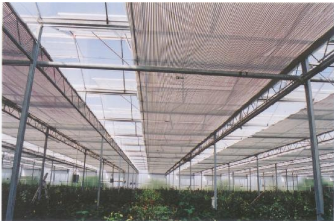
Φώτο 11: Κουρτίνες σκίασης στην οροφή του θερμοκηπίου.
