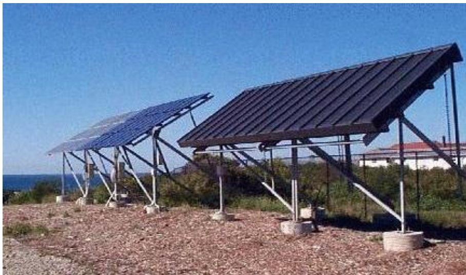
Σχήμα 2.15: Σταθερή τοποθέτηση φ/β συστοιχίας στο έδαφος.
