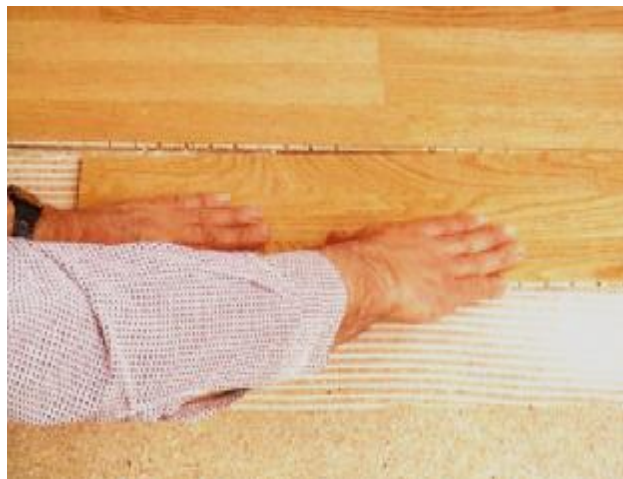
Σχήμα 10. Τοποθέτηση παρκέ
