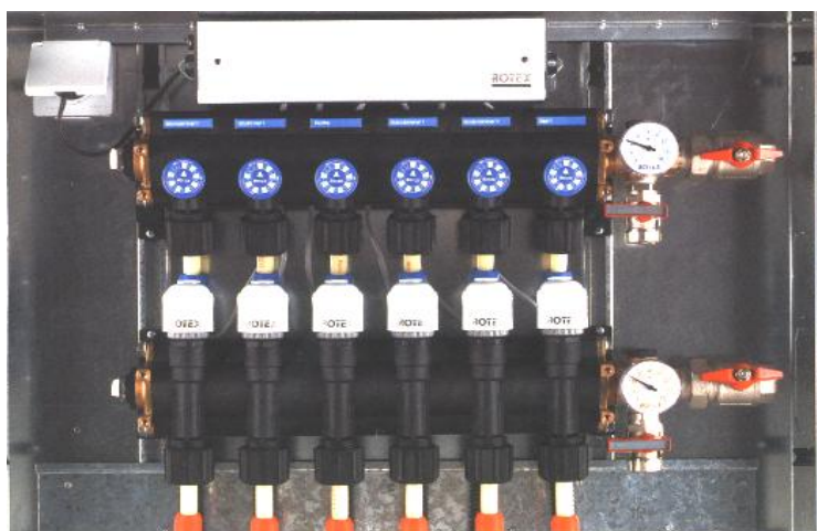
Σχήμα 6 Συλλέκτης κυκλωμάτων
