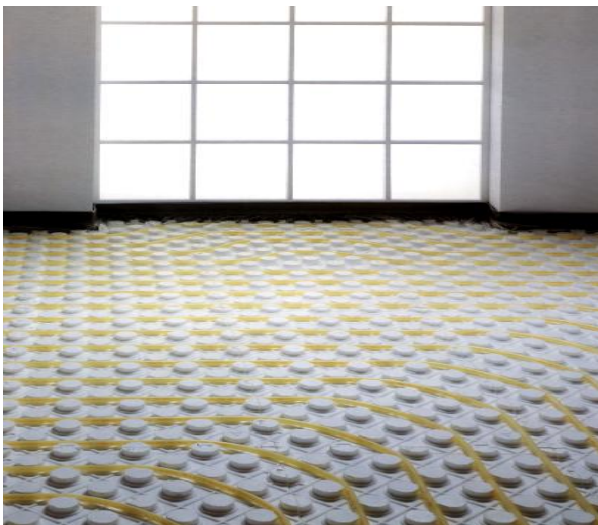
Σχήμα 3. Κύκλωμα ενδοδαπέδιου δικτύου
