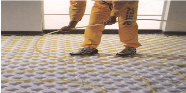
Σχήμα 9 . Εγκατάσταση θερμοσωλήνα
