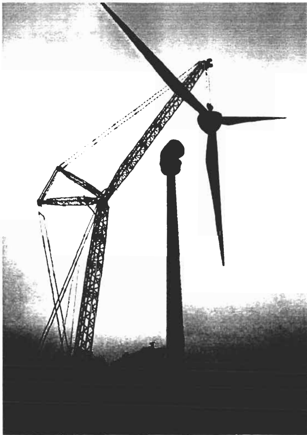
Εικόνα 51: Τοποθέτηση των περιγίων
