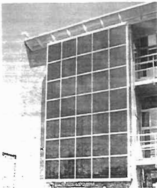
Σχήμα 4.1.5: Εφαρμογές PV σε νέα κτίρια. πρόσφιη κτιρίου 42 π 2 καλυμμένη από PV-πλαίσια, από άμορφο (a)Si.
