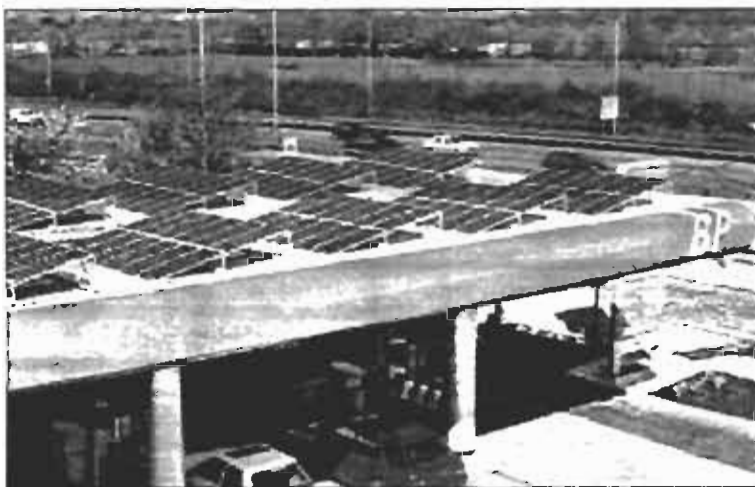
Σχήμα 4.1.10: Πρατήριο βενζίνης στο Λονδίνο που τροφοδοτείται με ενέργεια από φωτοβολταικά. Αποτελείται από 220 φωτοβολταικά πλαίσια συνολικής ισχύος 19kWp
