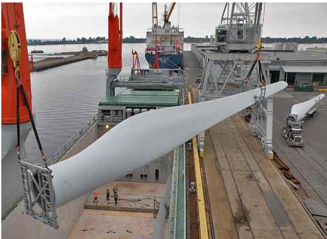
Εικόνα 4.1: Πτερύγιο Α/Γ κατά την μεταφορά του με πλοίο [19]
