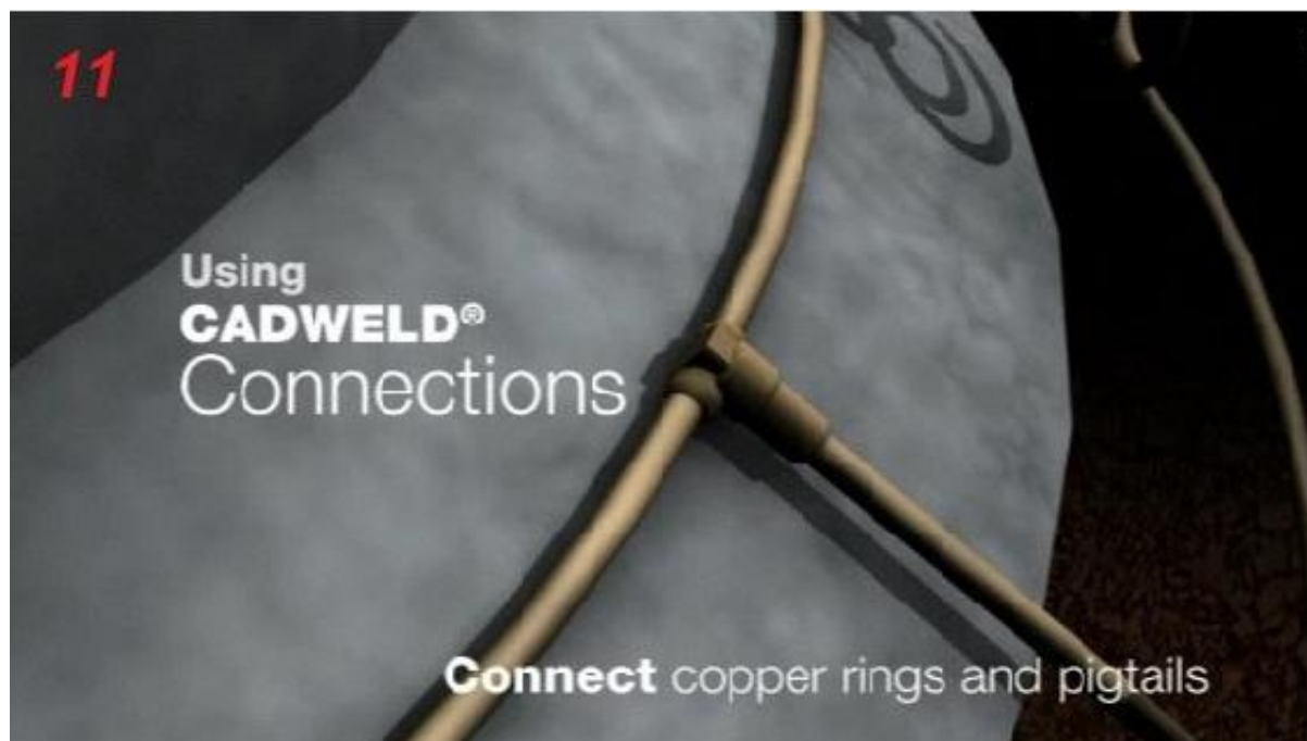
Εικόνα 5.77 : Σύνδεση χάλκινων δακτυλίων και πλεξίδων.[24]
