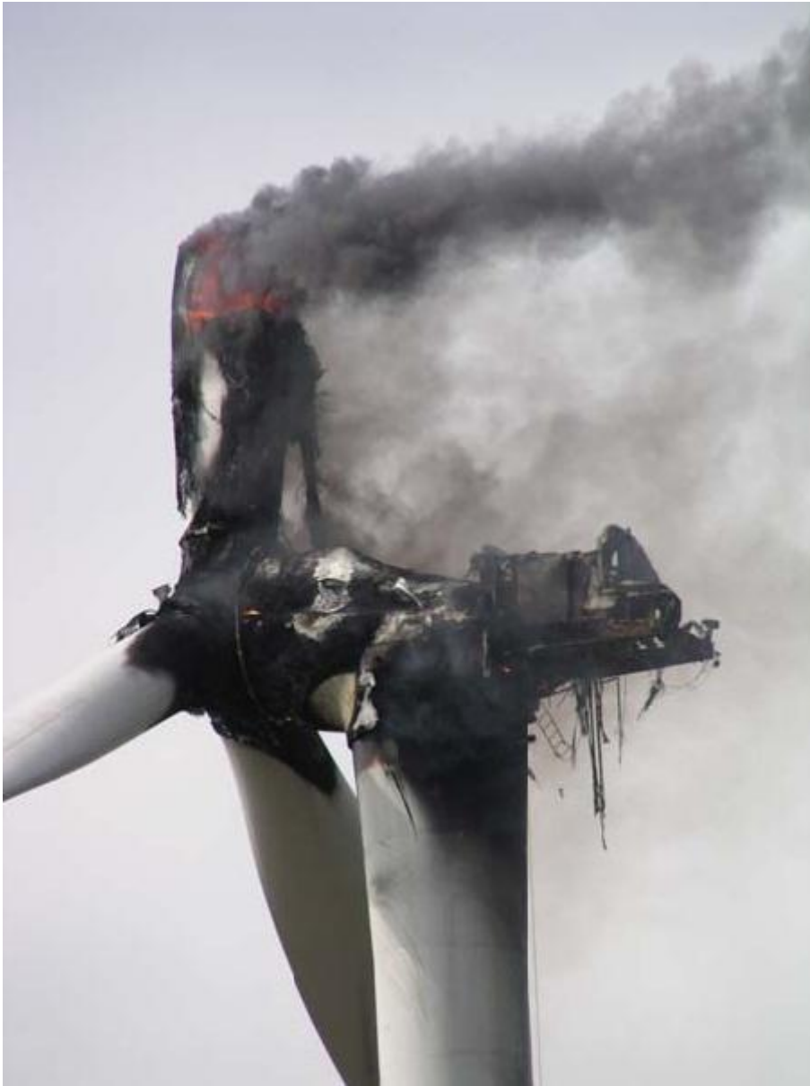
Εικόνα 4.4: Α/Γ μετά από πλήγμα κεραυνού [4]
