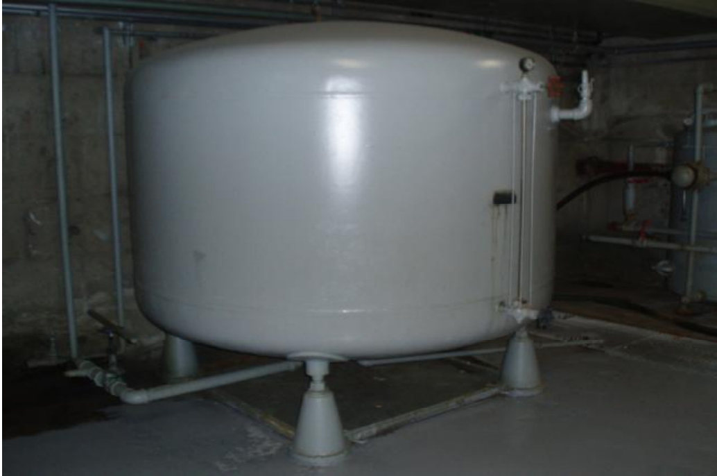
Φίλτρο νερού - χλωριοτής (εικόνα 3)
