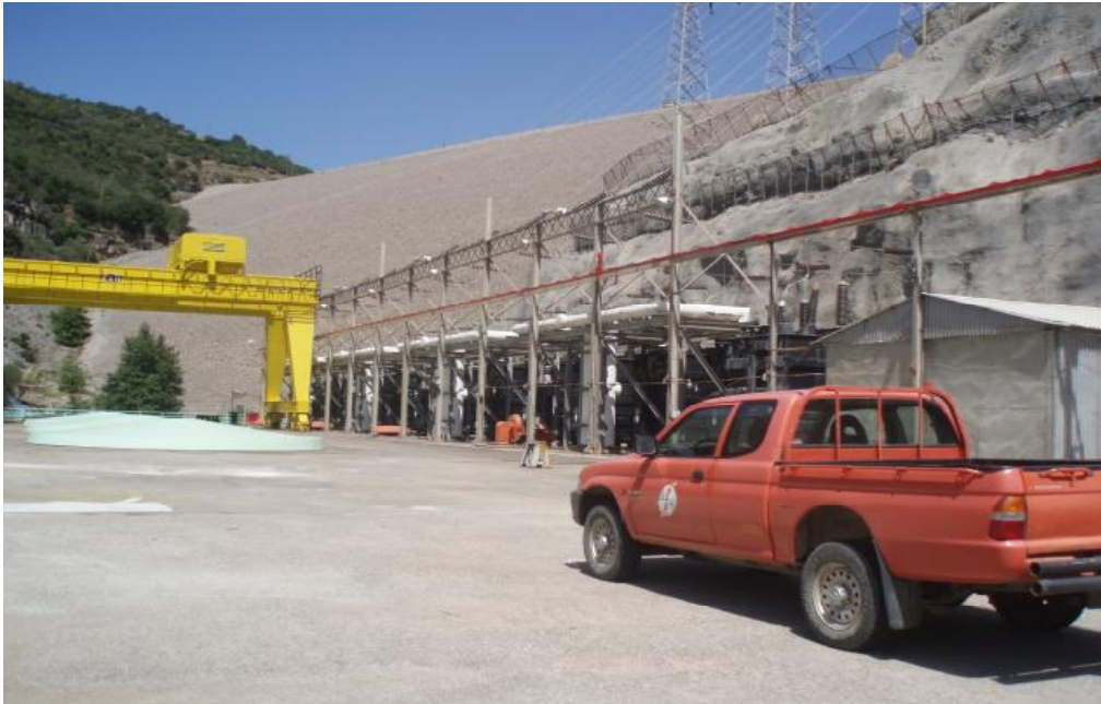
Μέρος του φράγματος επενδυμένο με μπετόν (εικόνα 1)
