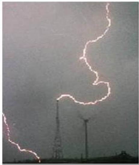
Σχήμα 20: Εκκένωση κεραυνού στον πυλώνα.
