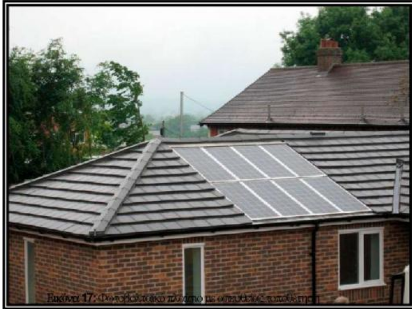
Φωτοβολταϊκό πλαίσιο με απευθείας τοποθέτηση
