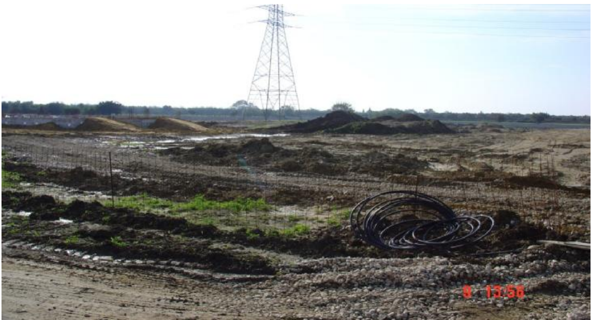
Σχήμα 9. Χωματουργικές εργασίες, σε υπό ανέγερση νέου Υ/Σ.
