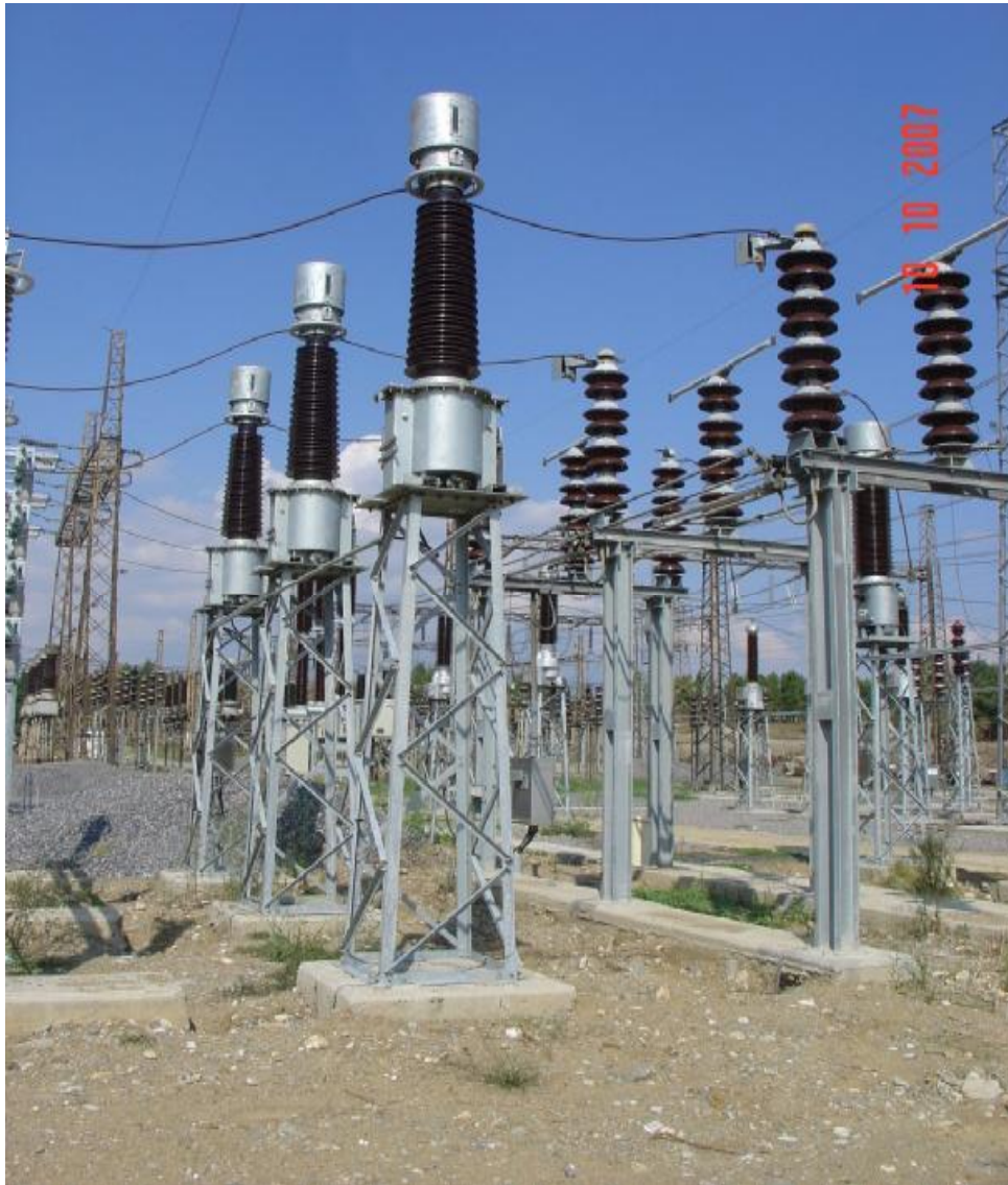
Σχήμα 38. Μ/Σ Έντασης σε πύλη ΓΡ. Υ.Τ.
