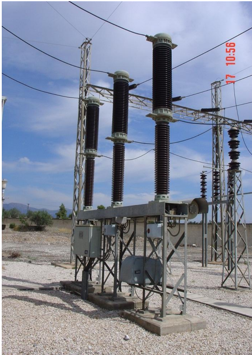
Σχήμα 34. ΑΕ/Δ 150KV με μέσον σβέσης τόξου SF 6 , με ένα θάλαμο διακοπής τόξου και πνευματικό χειριστήριο.
