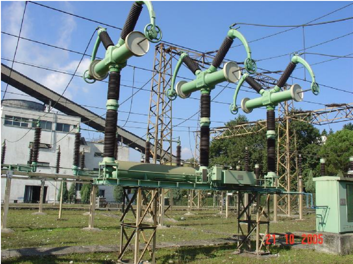
Σχήμα 33. Αεροδιακόπτης Ισχύος (Α/Δ) 150KV με δύο επαφές διακοπής τόξου..
