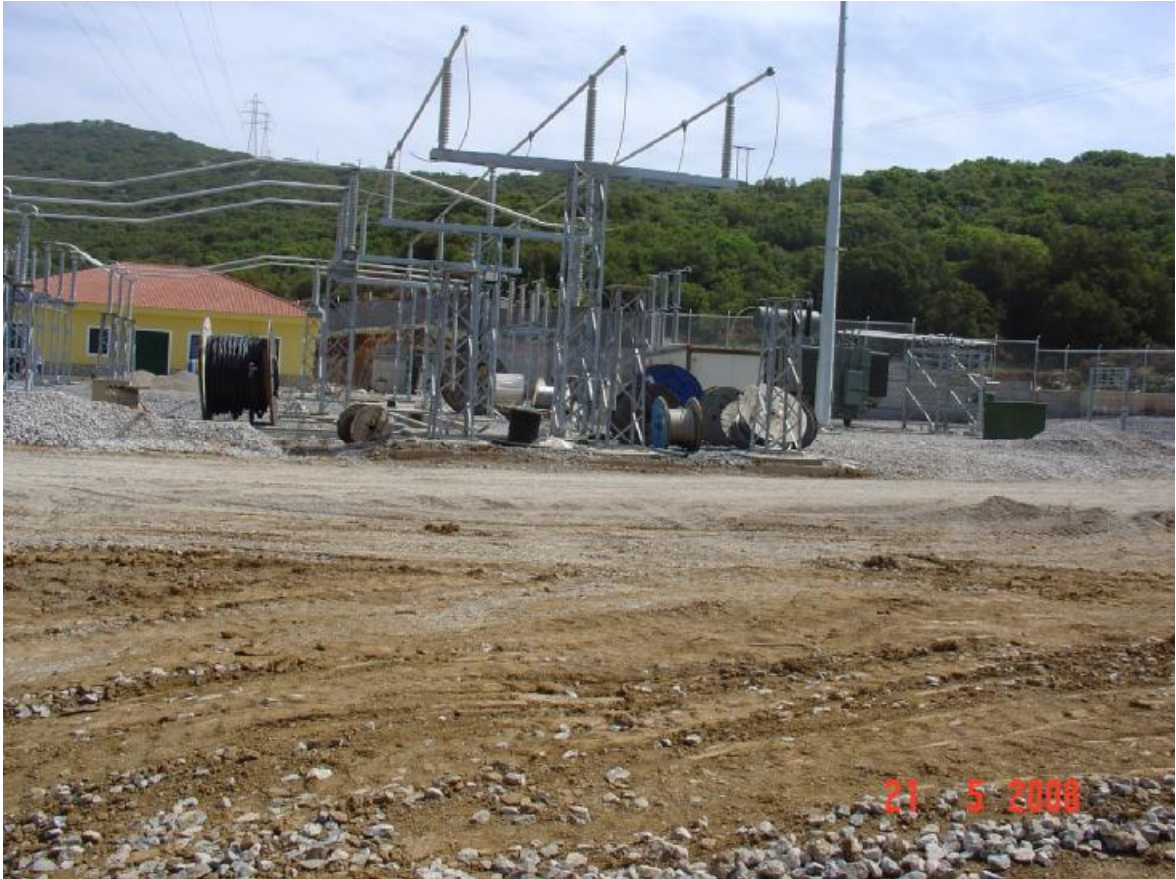
Σχήμα 11. Εγκατάσταση εξοπλισμού, σε υπό ανέγερση νέου Υ/Σ.
