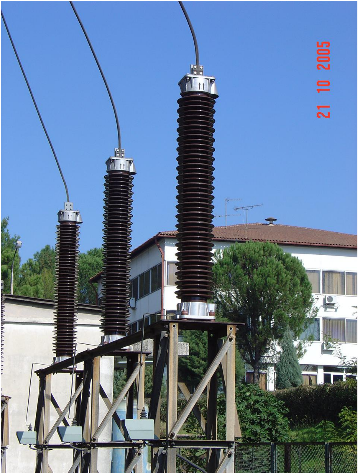
Σχήμα 46. Αλεξικέρανα ανά φάση, συνδεδεμένα παράλληλα με τη ΓΡ. Υ.Τ.
