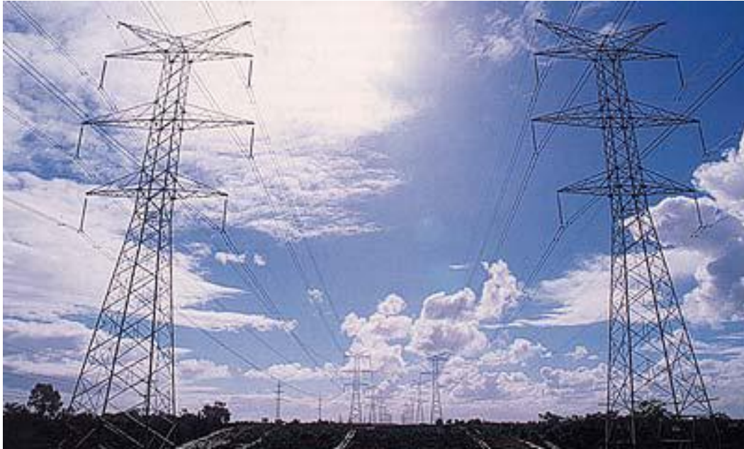
Σχήμα 3. Γραμμές Μεταφοράς ΥΥΤ (400kV), Διπλού κύκλώματος.
