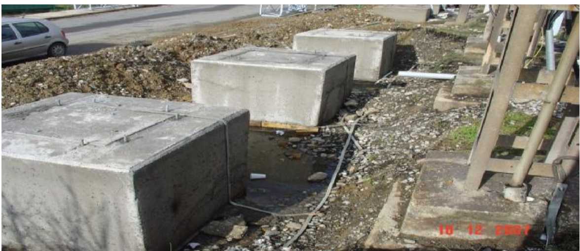
Σχήμα 10. Βάσης ικρωμάτων στήριξης πρωτεύοντος εξοπλισμού.
