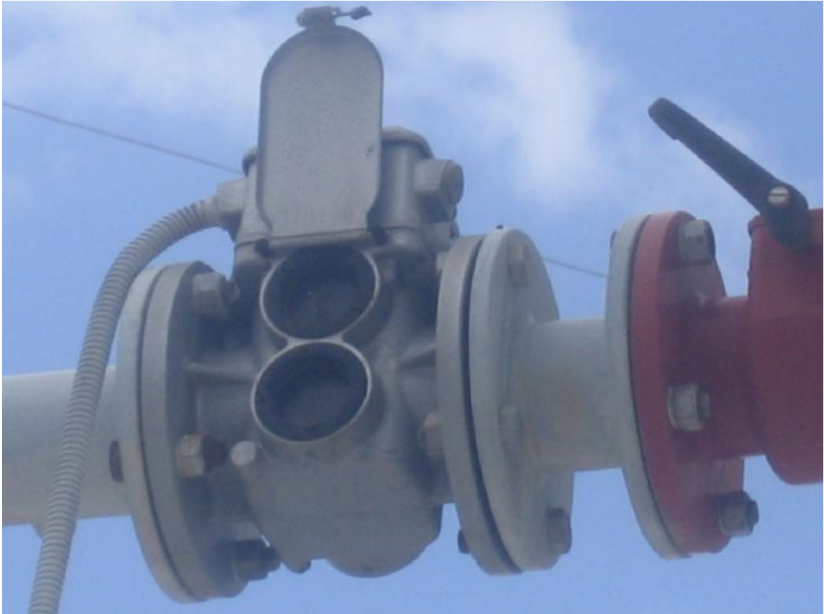
Σχήμα 26. Ηλεκτρονόμος- buchholz.
