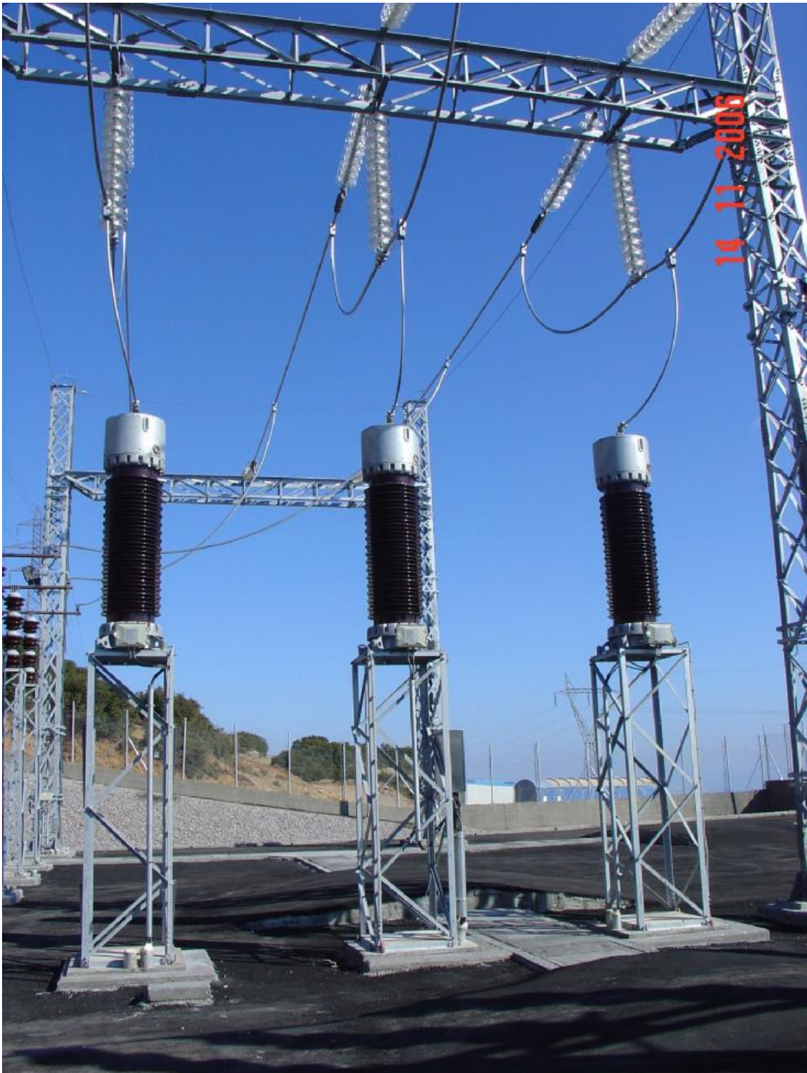
Σχήμα 42. Μ/Σ Τάσης, σε παράλληλη σύνδεση του πρωτεύοντος με την Υ.Τ.
