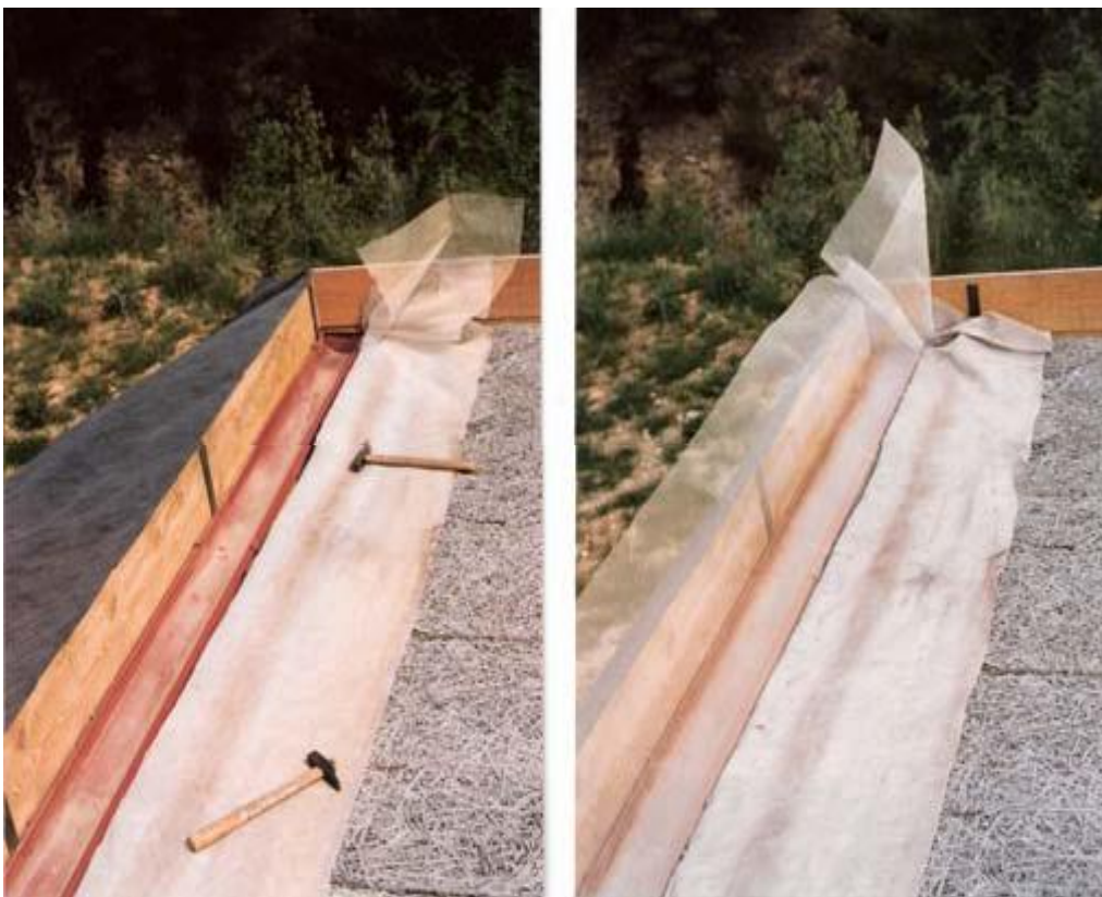
Εικόνα: Κατασκευή φυτεμένης στέγης
