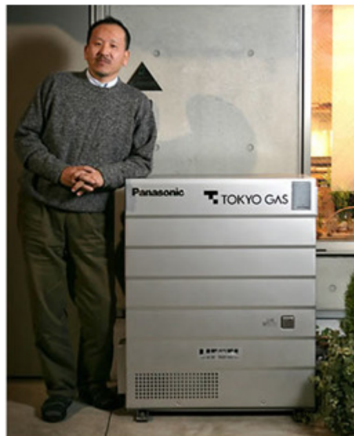
Σχήμα 2.3: Κυψέλη καυσίμου για χρήση σε ιαπωνική κατοικία.
