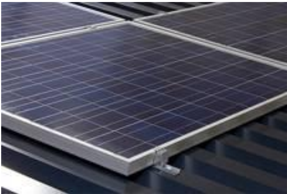
Εικόνα 3. Στήριξη πάνελ με αγκίστρια
