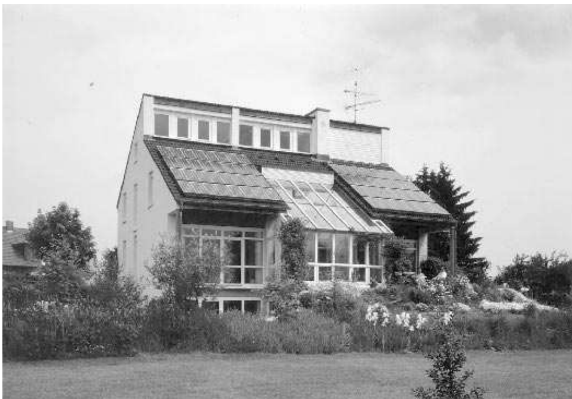
Σχήμα 2.7 Η αποκεντρωμένη παραγωγή ενέργειας μέσω φωτοβολταϊκών συστημάτων. Η οροφή ολοκληρωμένων φωτοβολταϊκών σύστημα έχει τη μέγιστη τιμή ισχύος 5 kw
