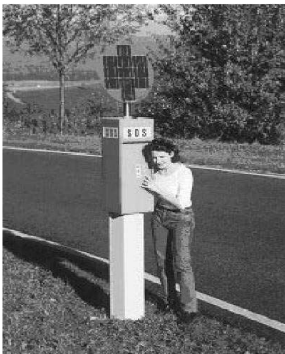
Σχήμα 2.13 τηλέφωνο έκτακτης ανάγκης. Αυτόνομο πληροφοριακό σύστημα που χρησιμοποιεί φωτοβολταϊκά τροφοδοσία
