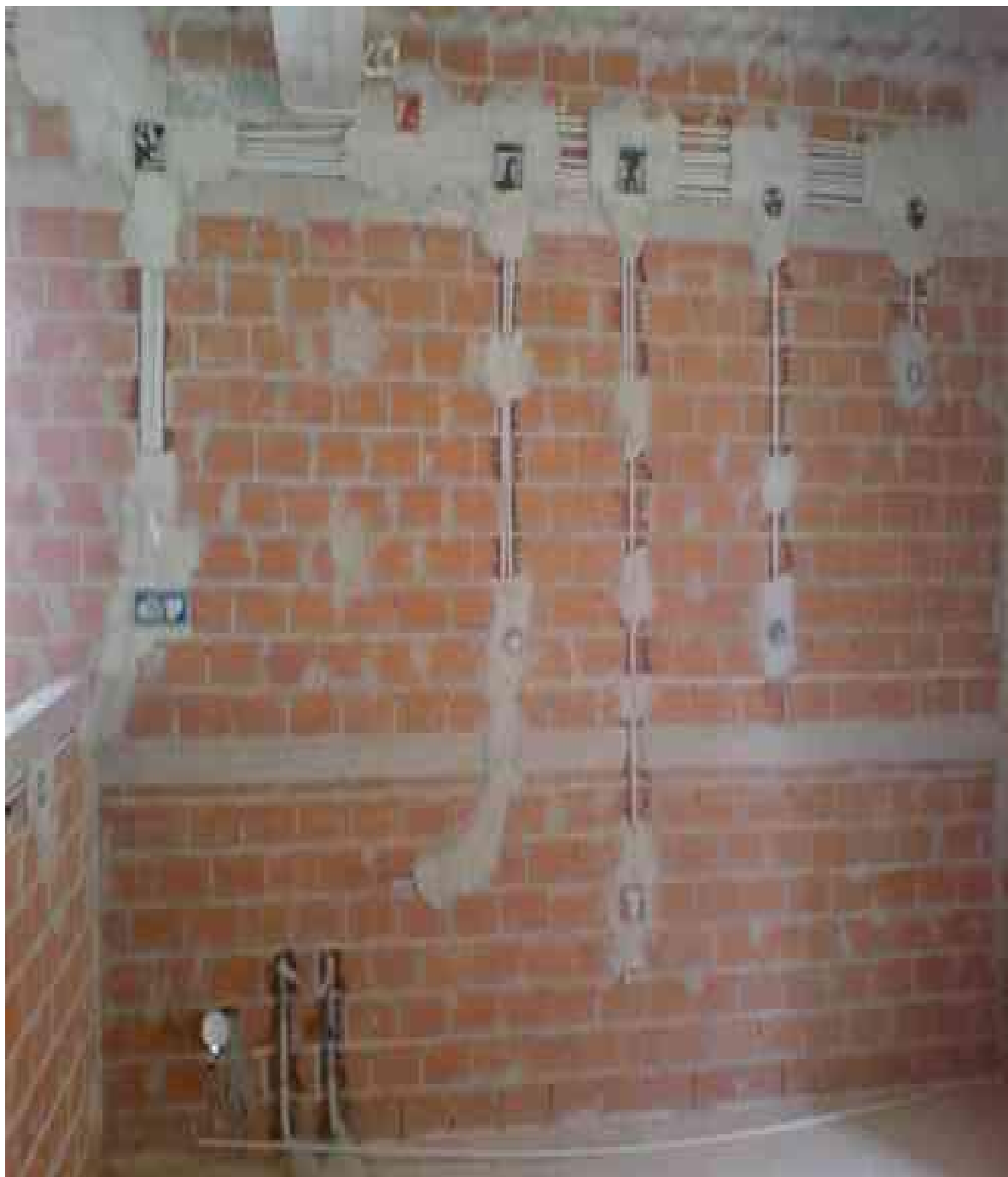
ΕΓΚΑΤΑΣΤΑΣΗ ΜΕ ΧΩΝΕΥΤΕΣ ΣΩΛΗΝΩΣΕΙΣ
