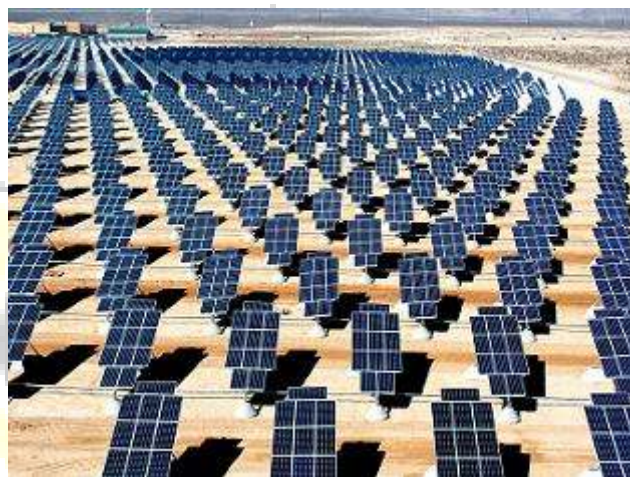
Εγκατάσταση επίπεδων ΦΒ διατάξεων
